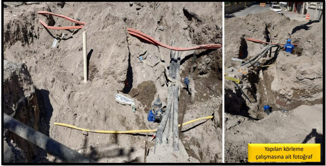
Şekil 6.12 Bölgedeki körleme çalışmaları (K-1)
