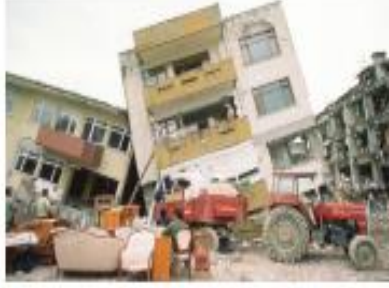
3.39 Depremde yıkılan binalar (Yalova)
