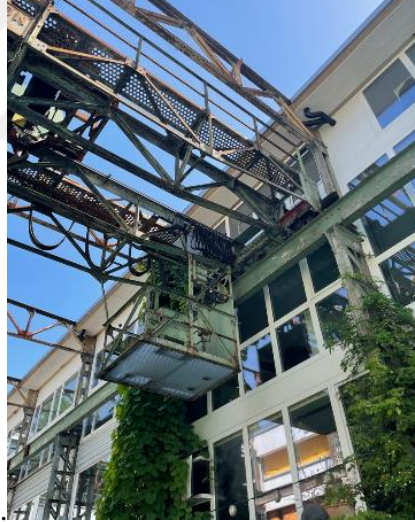
Şekil 3.17 : a. Kompleksin içinde oluşturulan orta bahçe, b. Orta bahçedeki eski fabrika binasına ait bırakılan taşıyıcı elemanlar (A. Köprülü Arşivi).
