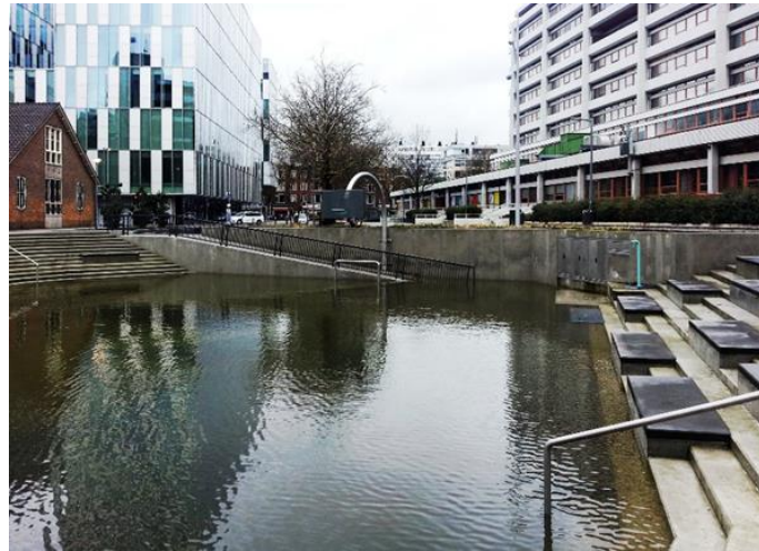
Şekil 2.15 : Benthemplein su plazasının yağış sonrası durumu (Url-8).
