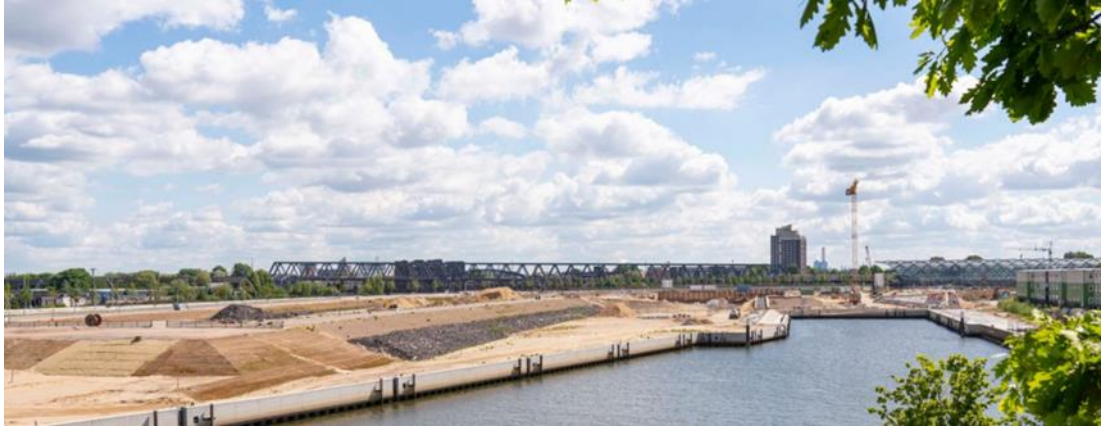
Şekil 4.26 : Hafencity yükseltilmiş plato yapımı (Url-41).
