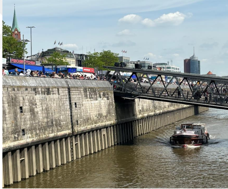
Şekil 4.30 : Landungsbrücken sel duvarı (Yazarın kendi arşivi, 2024).
