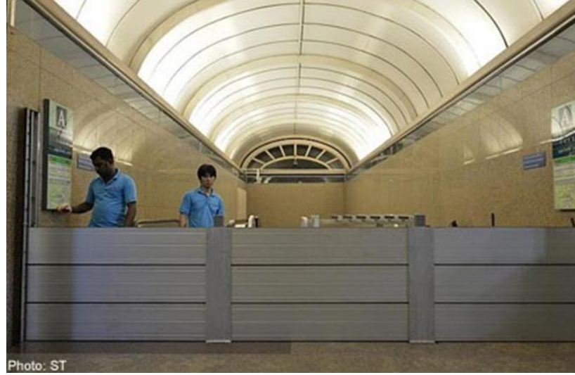
Şekil 2.28 : MRT girişine yerleştirilen modüler sel bariyeri (MEWR-MND, 2016).
