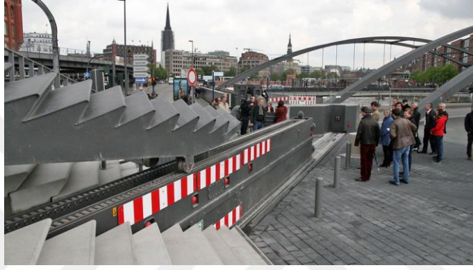
Şekil 4.34 : Niederhafen promenadının basamaklarına gizlenmiş kayar kapı (Url-46).
