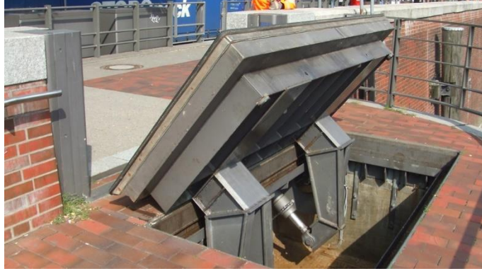
Şekil 4.33 : Kibbelstegbrücke’de bulunan katlanır kapı (Url-45).
