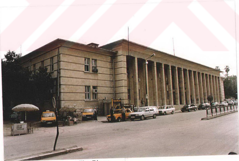
Şekil 89. Adana Adliye Binası
