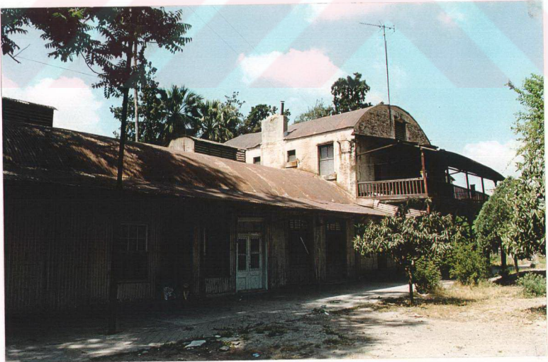
Şekil 4.7. Adana Eski İstasyon Binası
