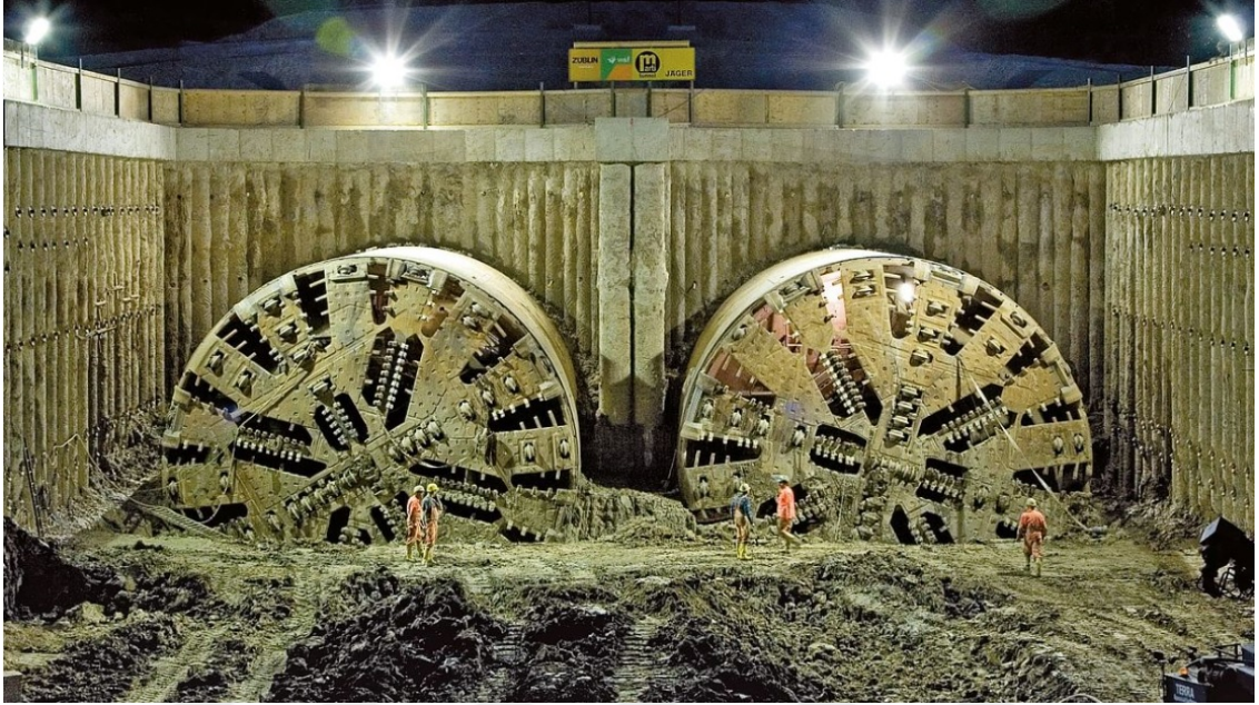
Şekil 2.9 Çift tüplü EPB-TBM ile açılmış bir tünel (Anonymous 7, 2023)
