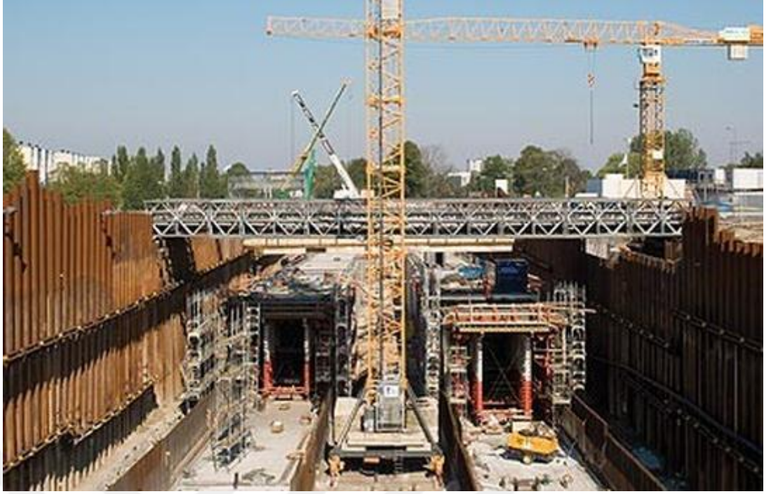
Şekil 2.2 İnşası devam eder aç – kapa yöntemi ile açılan bir tünel (Anonymous 1, 2023)
