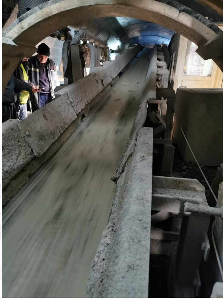
Şekil 3.12. Hadim-Afşar-Bağbaşı su ikmal tüneline numune alma işlemi
