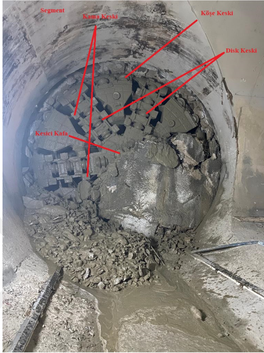
Şekil 3.11. Çekmeköy-Sancaktepe-Sultanbeyli metro projesinde kullanılan EPB-TBMin kazı sonu gösterimi
