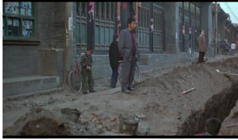
Görsel 43: Sokakta yol çalışması (Platform)
