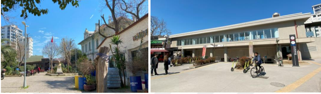
Şekil 4.55 Bostancı istasyonu eski istasyon yapısı (sol) ve Marmaray yapısı (sağ)
