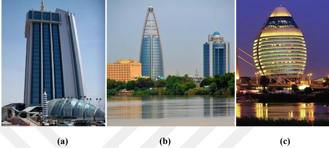
Şekil 3.4. Nehir Kenarındaki Modern Bina Örnekleri a) İtisalat Kulesi; b) Elsunnt Kuleleri; c) Corinthia Otel
