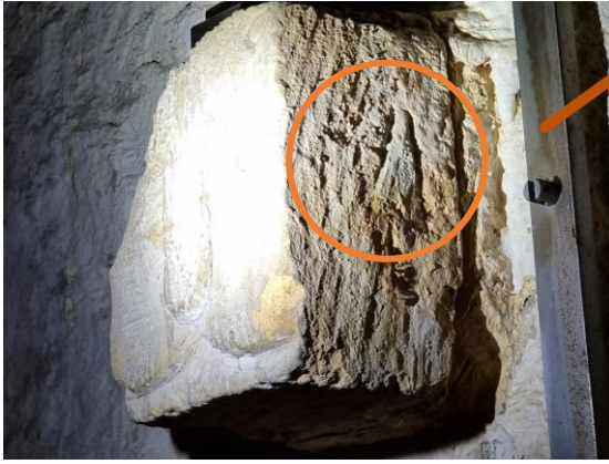
Levha 4. Alara Hanı'nda Aslan Başlı Konsollarda Taşçı İşareti Kullanımı. (Soldan Sağa 22-1 ve 52-5)
