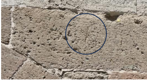
Levha 21. Karatay Hanı'nda Kesilmiş Taşlar Üzerinde Bulunan Taşçı İşaretleri. Katalog Numaraları: 1: 13-5; 2: 5-6; 3: 18-9; 4: 13-5; 5: 18-5 ve 18-6.
