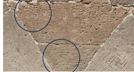
Levha 21. Karatay Hanı'nda Kesilmiş Taşlar Üzerinde Bulunan Taşçı İşaretleri. Katalog Numaraları: 1: 13-5; 2: 5-6; 3: 18-9; 4: 13-5; 5: 18-5 ve 18-6.
