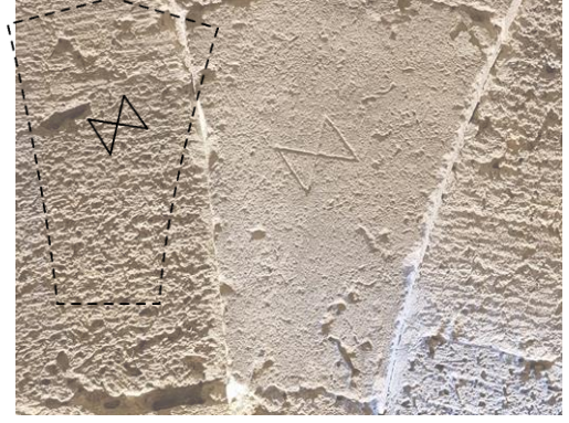
Foto. 6. Aksaray Sultan Hanı Farklı Formdaki Taşlar Üzerinde Taşçı İşaretleri (Kat. No.:27-1).
