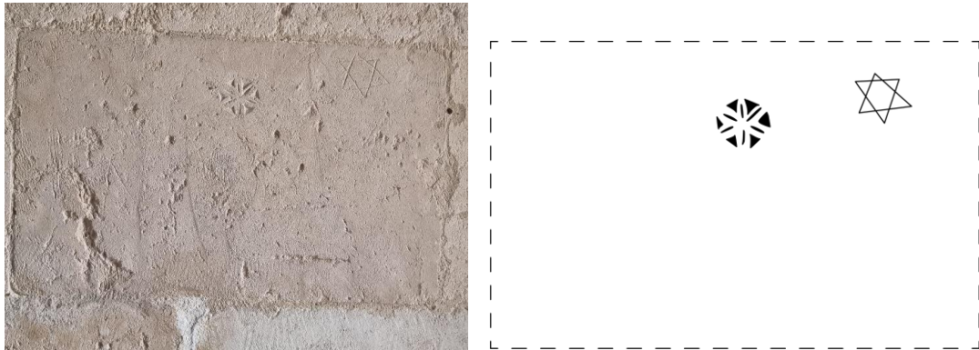
Levha 18. Tercan Mama Hatun Kervansarayı, 38b-12 ve 41a-2 Katalog Numaralı İşaretlerin Tek Taş Üzerinde Kullanılması.
