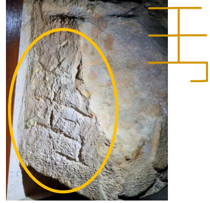
Levha 4. Alara Hanı'nda Aslan Başlı Konsollarda Taşçı İşareti Kullanımı. (Soldan Sağa 22-1 ve 52-5)
