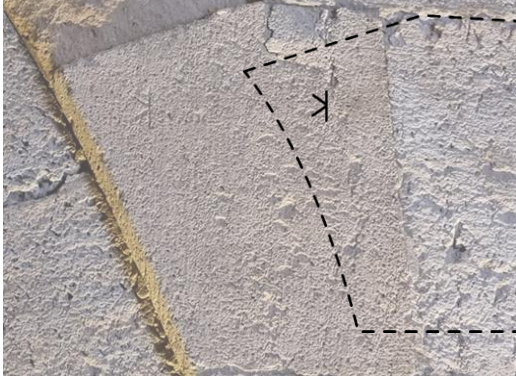
Foto. 5. Aksaray Sultan Hanı Farklı Formdaki Taşlar Üzerinde Taşçı İşaretleri (Kat. No.:19-1).
