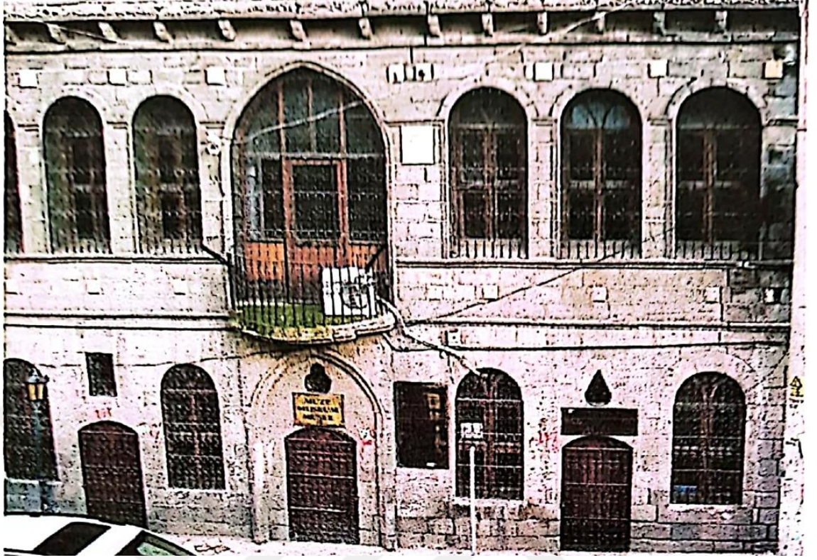
Resim 7: Cizre Eski Belediye Binası (Müze)
