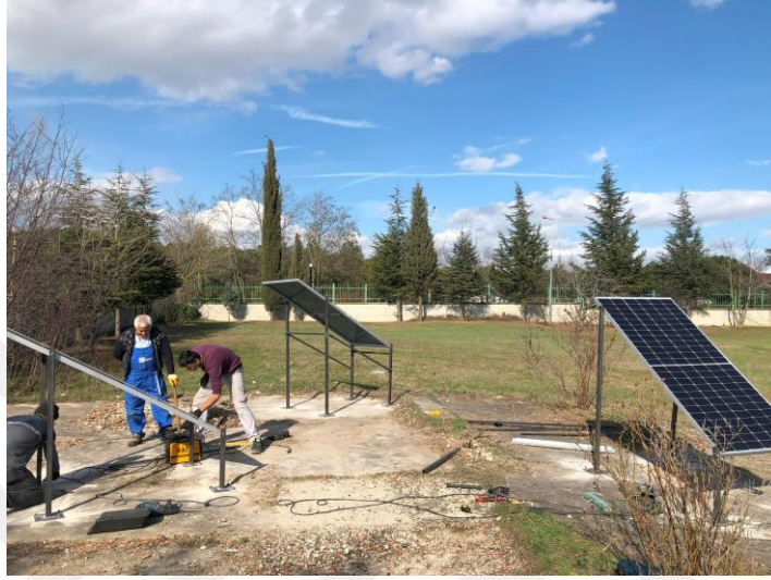
Şekil 3.15. Fotovoltaik panel düzeneğinin kurulması
