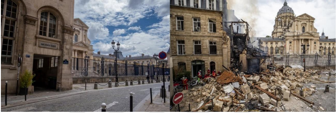
Şekil 1.3 Paris American Academy binasının patlama öncesi ve sonrası a) Patlamadan önce, b) Patlamadan sonra [23], [24]
