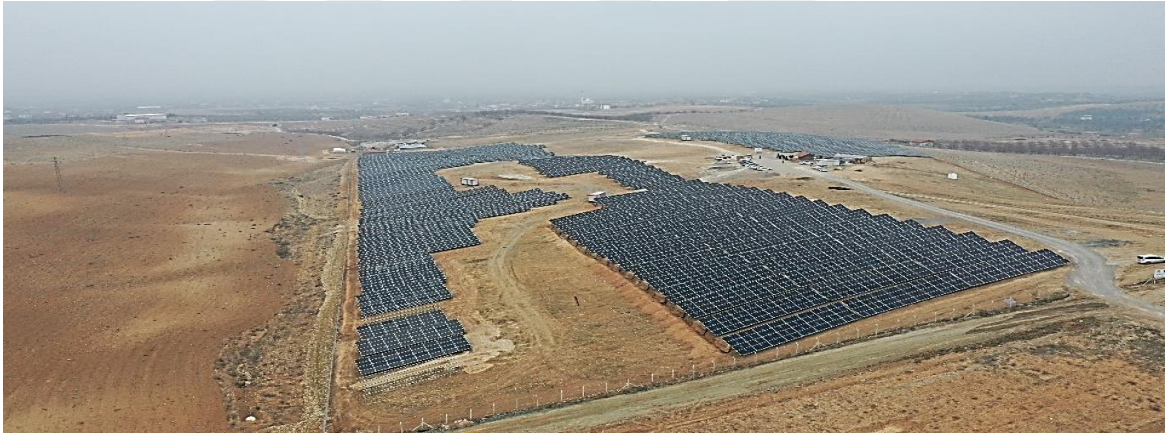
Şekil 4.3: Yaka Mahallesi Güneş Enerjisi Santrali (MASKİ, 2023).
