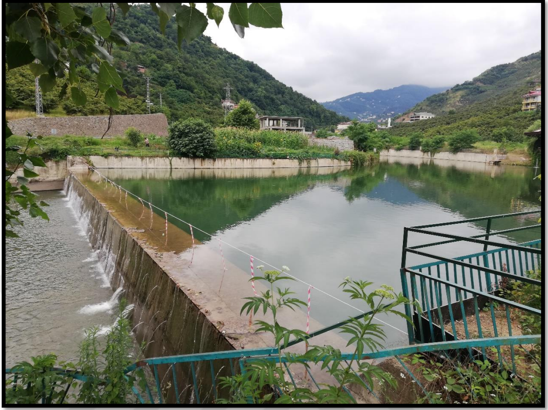
Fotoğraf 21. Yıldızlı Deresi Sera Gölü'ne ulaşmadan önce farklı kot seviyelerinde setlenmiş ve sediman buralarda tutulmaya çalışılmıştır. Bu set her yıl düzenli olarak temizlenip boşaltılmaktadır.
