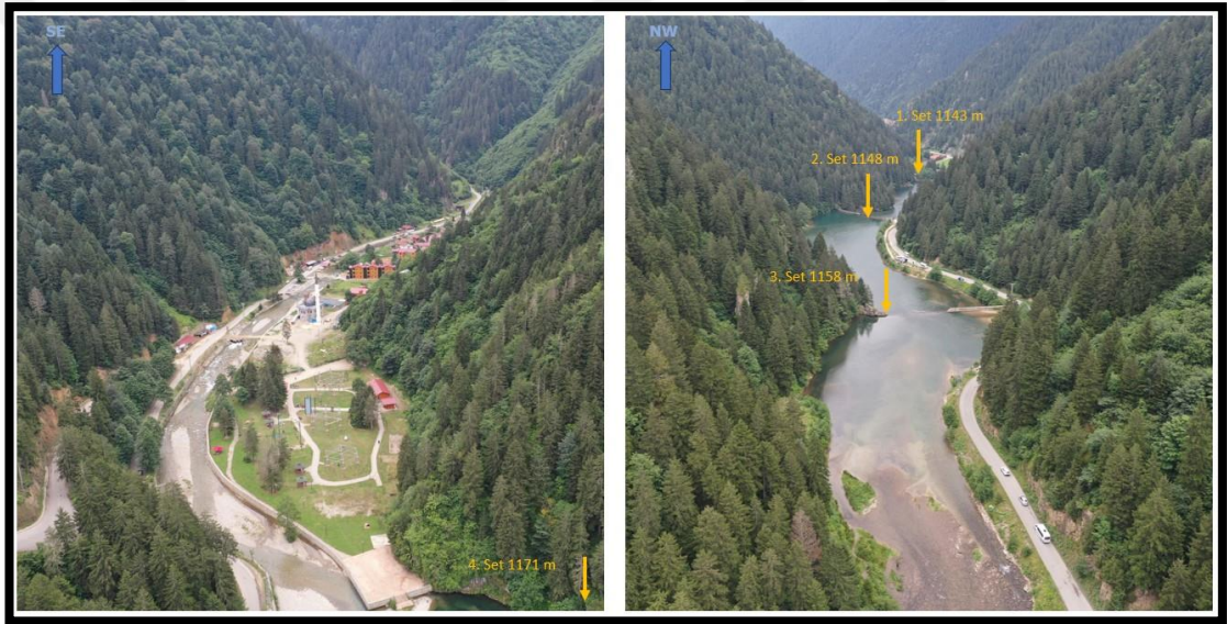
Fotoğraf 28. Uzungöl'e gelen Demirkapı Deresi üzerindeki setleme ve sedimanı tutma çalışmalarından örnekler
