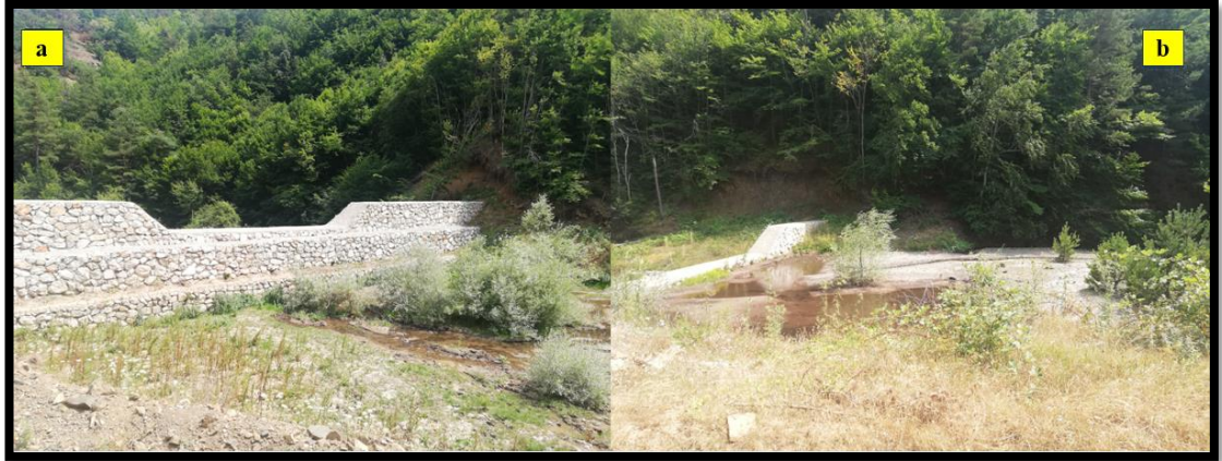
Fotoğraf 8. Boraboy Gölü'ne gelen Çatağın Deresi üzerindeki setleme ve sedimanı tutma çalışmalarından örnekler, a) 1075 m rakımdaki setin durumu ve b) 1129 m rakımdaki setin durumu.
