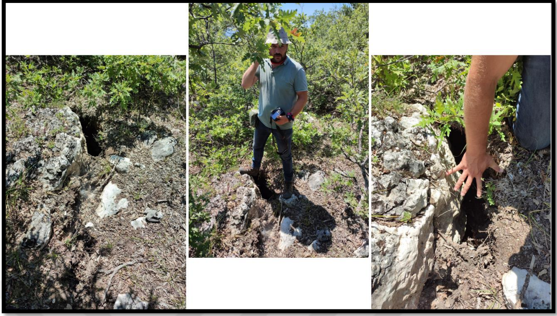
Fotoğraf 10. Zinav Gölü'nün doğusunda Bereketli üyesi (Krb) formasyonu üzerinde heyelan taş bölgesinde gerilme çatlakları ve meşe ( Quercus ) bitki örtüsünden görünümeler.
