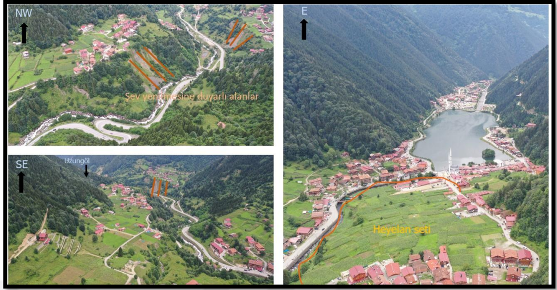
Fotoğraf 29. Uzungöl’ü oluşturan heyelan seti üzerinde şev yenilmesine duyarlı alanlar ve heyelan risk durumu.
