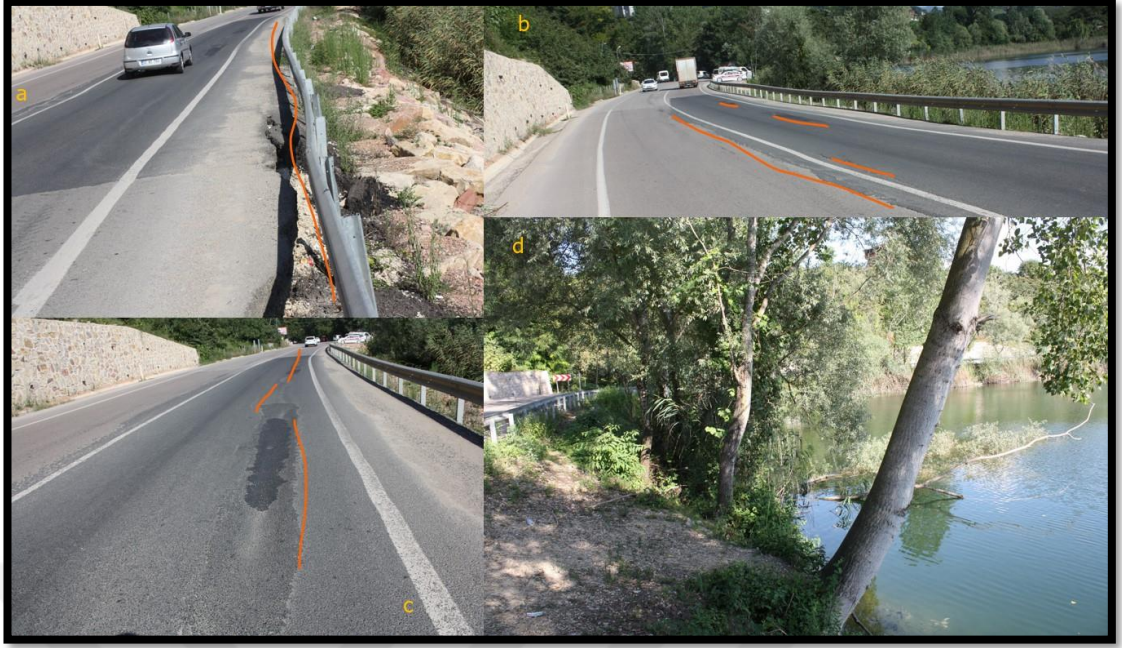
Fotoğraf 19. a) Gaga Gölü’nün kuzeyindeki Fatsa – Aybastı karayolunda krip ve yanıl yayılma etkisi ile yol kenarı koruyucu bariyerlerde eğilme. b - c) Yol üzerinde krip ve yanıl yayılma sonucu deformasyonlar ve asfalt tamiri. d) Kütle hareketinin ağaçlar üzerindeki etkisi (yavaş akma-krip)
