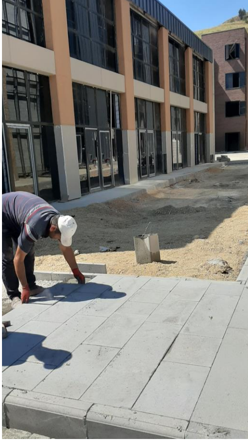
a) Atölye binası-garaj binası arası
