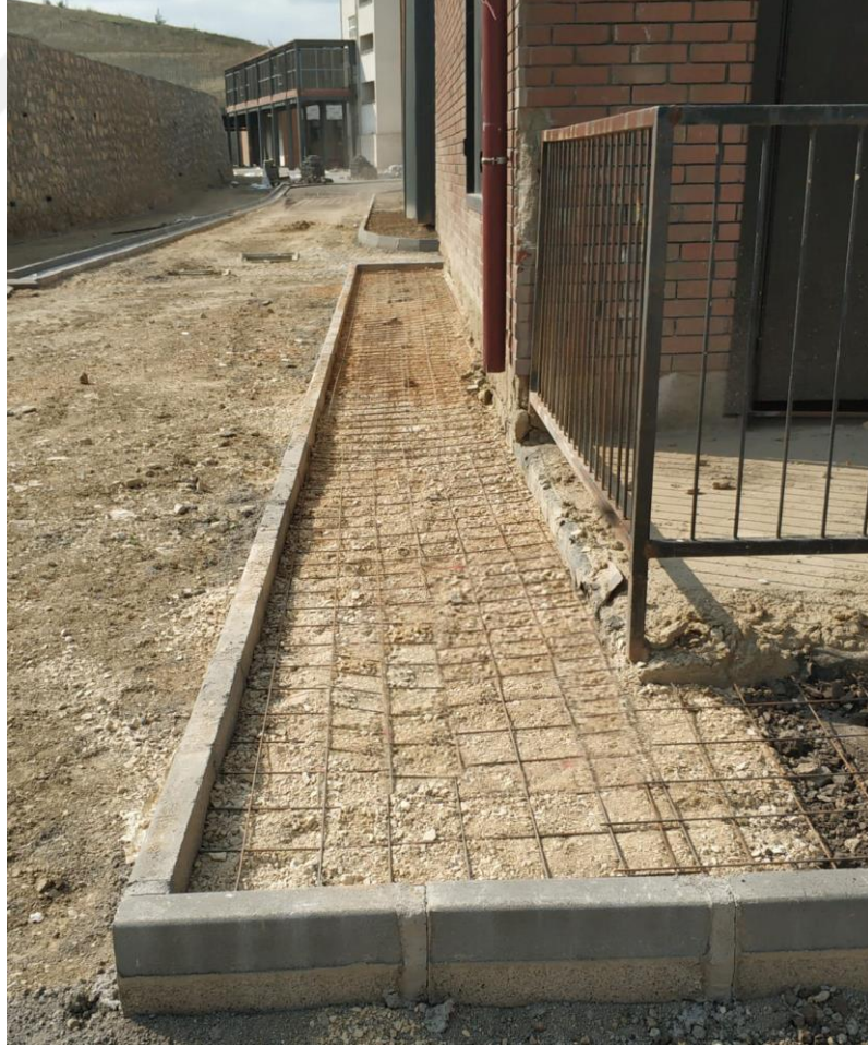
Şekil 3.31. İtfaiye eğitim binası tretuvar imalatı.
