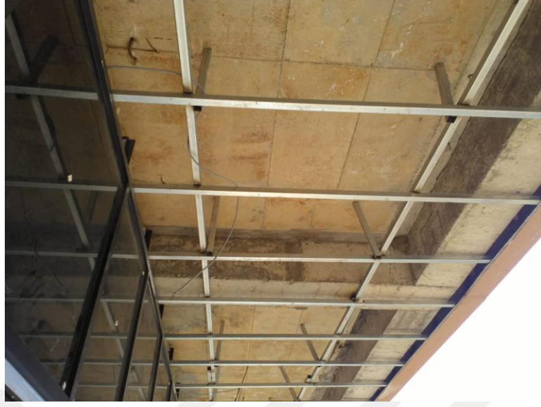
Şekil 3.30. Yemekhane binası alın kısmı fibercement kaplaması imalatı öncesi profil güçlendirmesinden görünüm.
