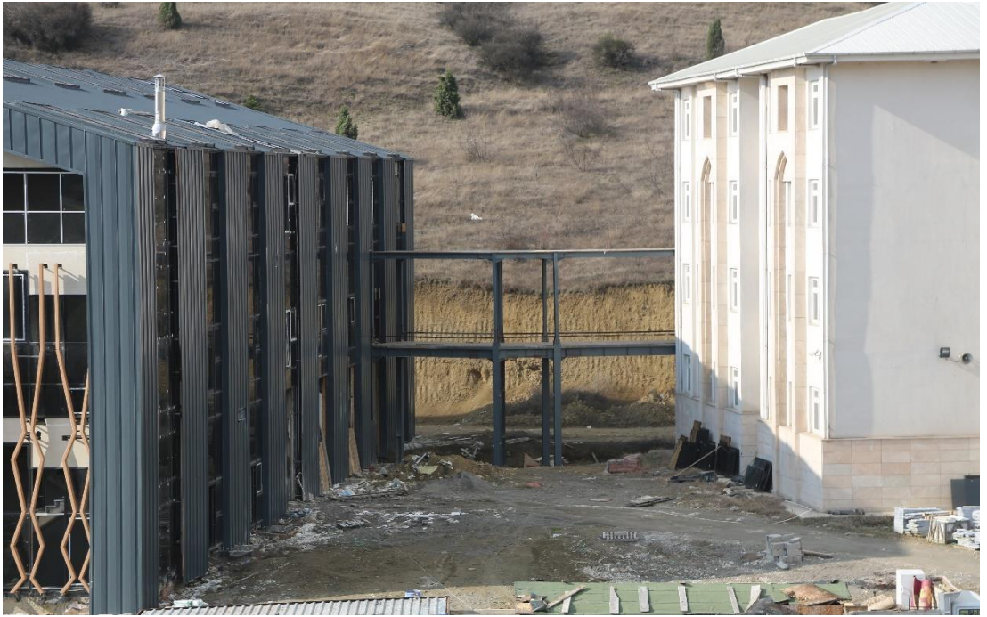
Şekil 3.9. Fesih sonrası atölye binası-ana bina arası köprüünün durumu.
