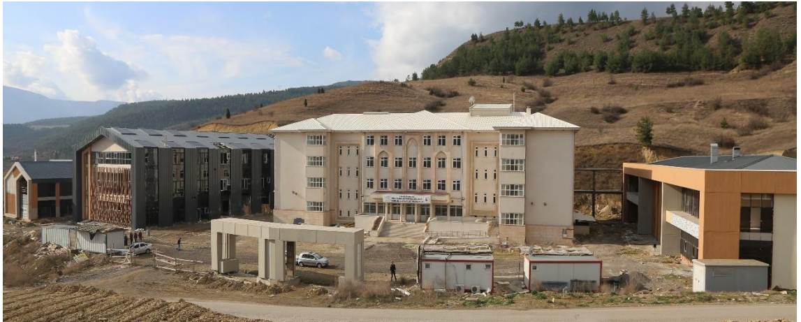
Şekil 3.6. Fesih sonrası şantiye genel durumunun görseli.
