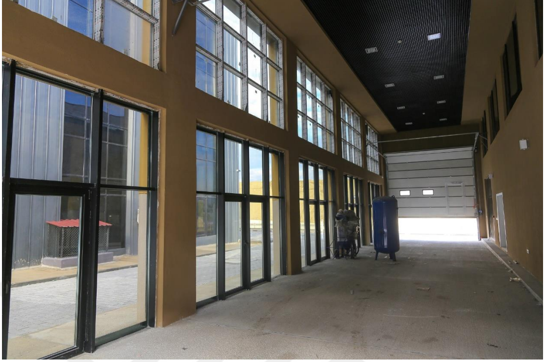
Şekil 3.42. İtfaiye garaj binası-İtfaiye giriş alanından bir görünüm.
