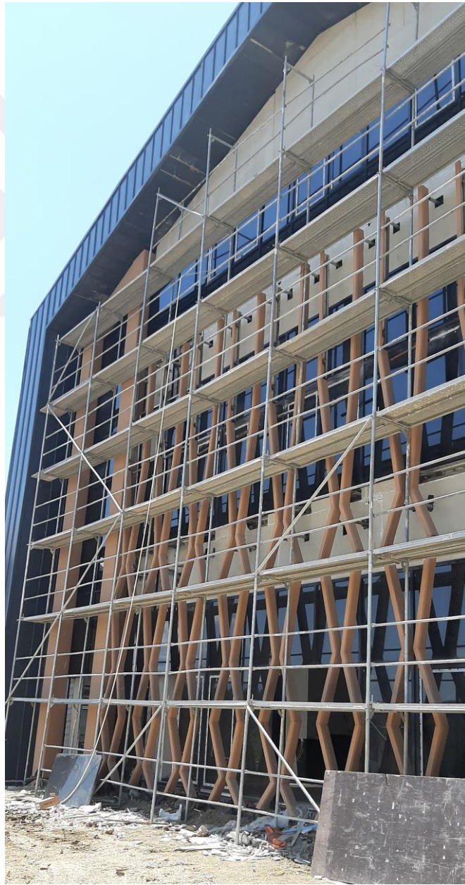
Şekil 3.29. Atölye binası ön cephe imalatlarının tamamlanması
