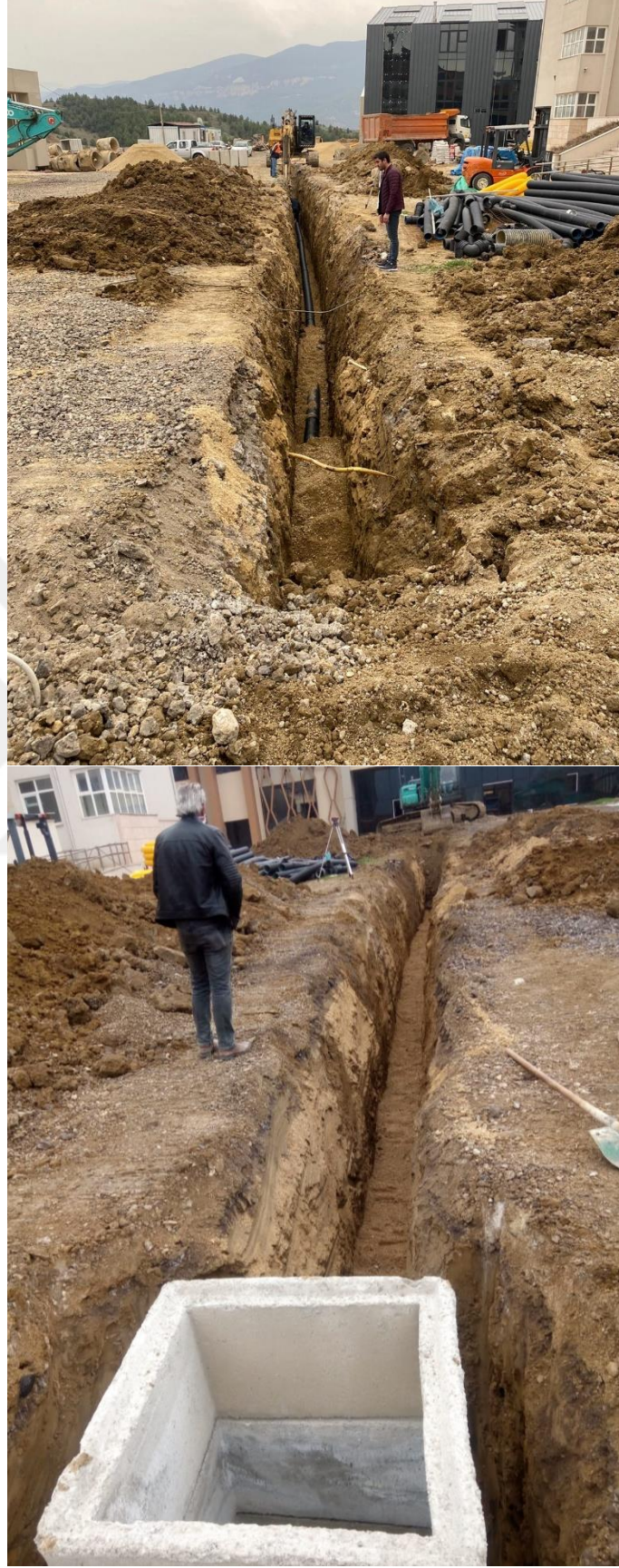
Şekil 3.24. Ana bina önünde yapımına başlanılan kanalizasyon imalatları.
