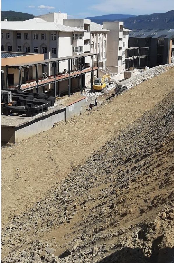
Şekil 3.21. Yamaç tarafında şevli kazı ve taş duvar imalatının görünümü.
