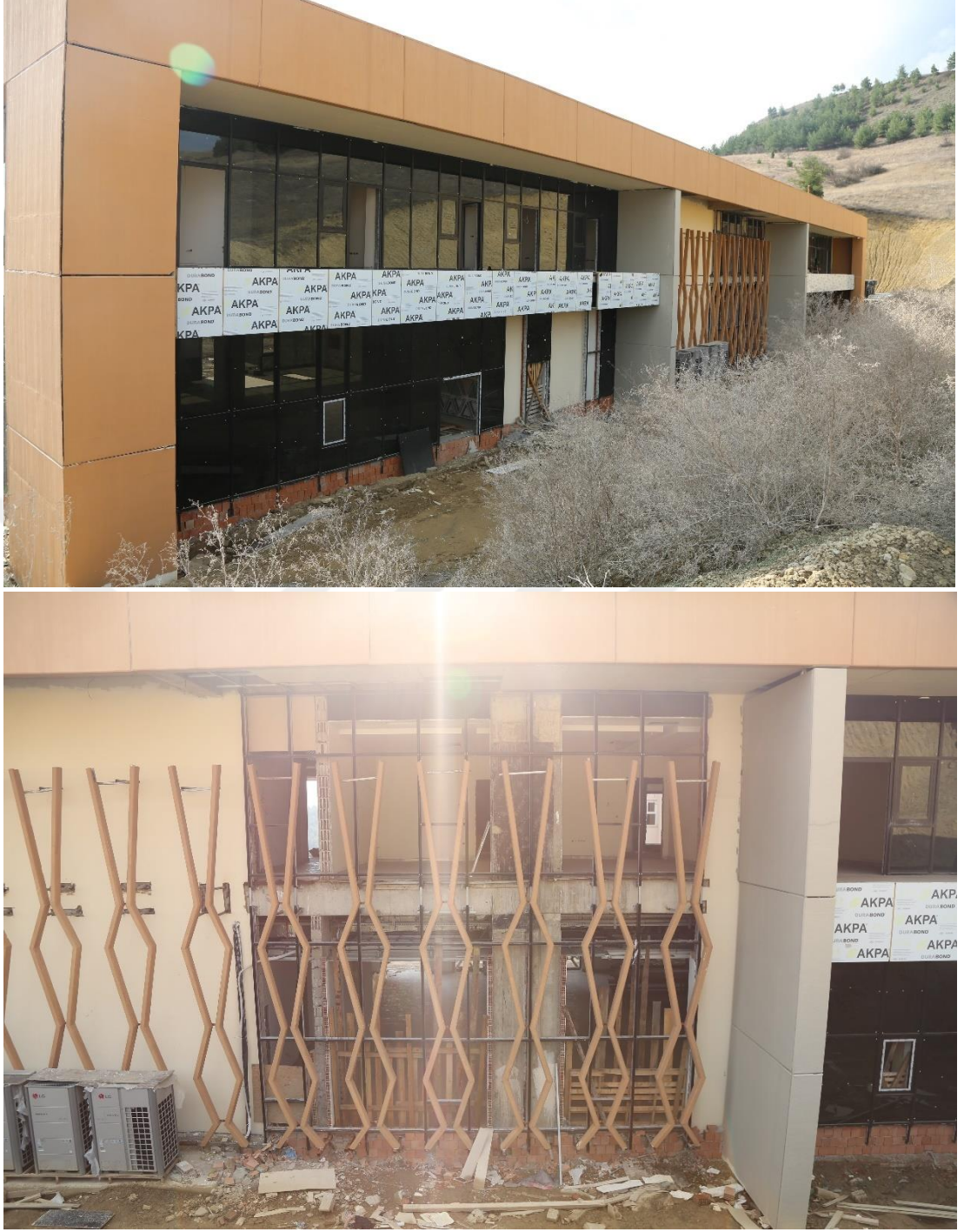
Şekil 3.12. Fesih sonrası yemekhane binası arka cephesinin durumu.
