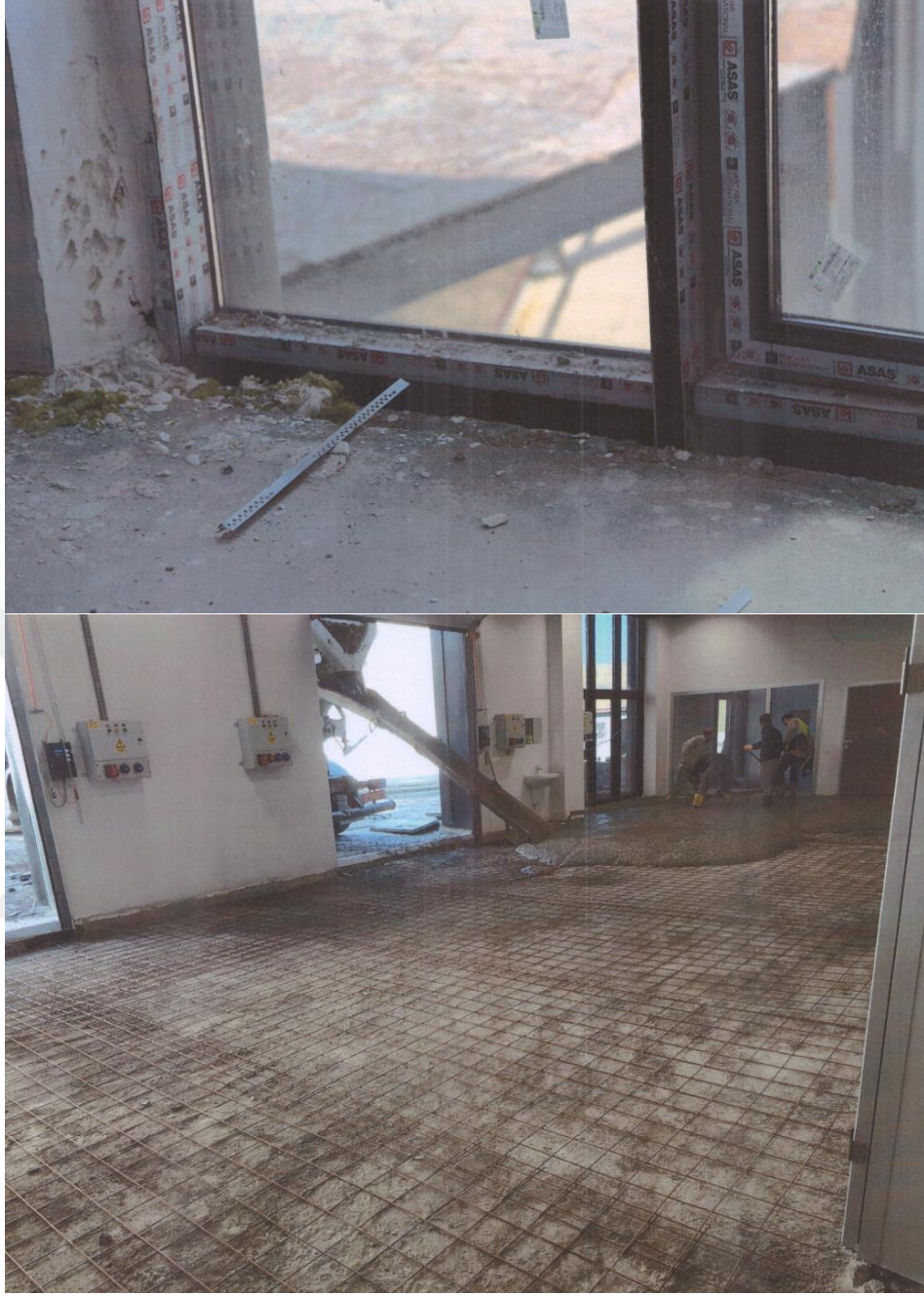
Şekil 3.36. Atölye binası zemin kat tesviye betonunun yenilenmesi ve ilk yüklenicinin yarım bıraktığı alüminyum doğrama ile döşeme arası boşlukların kapatılması imalatları.
