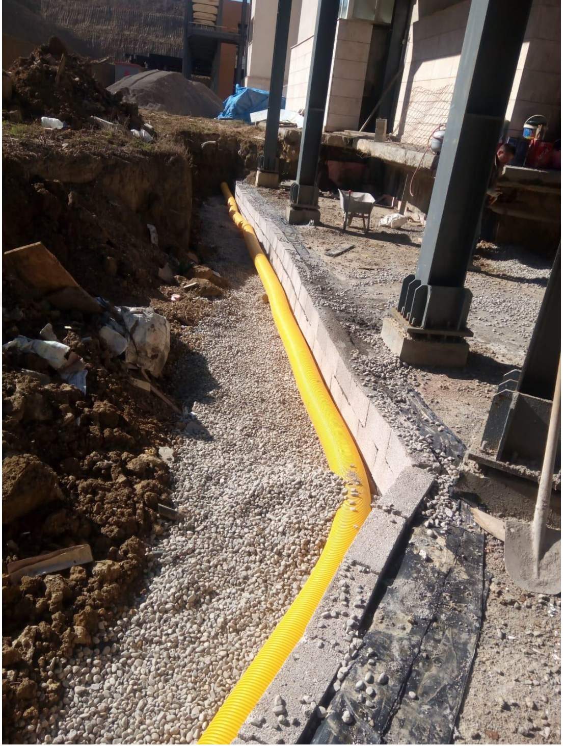
Şekil 3.22. Ana bina-atölye binası arasındaki köprünün drenaj imalatları görünümü.
