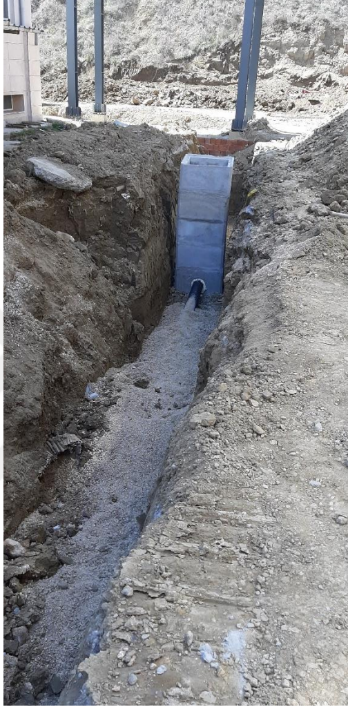
Şekil 3.23. Yemekhane binası önünde yapımına başlanılan kanalizasyon imalatları.
