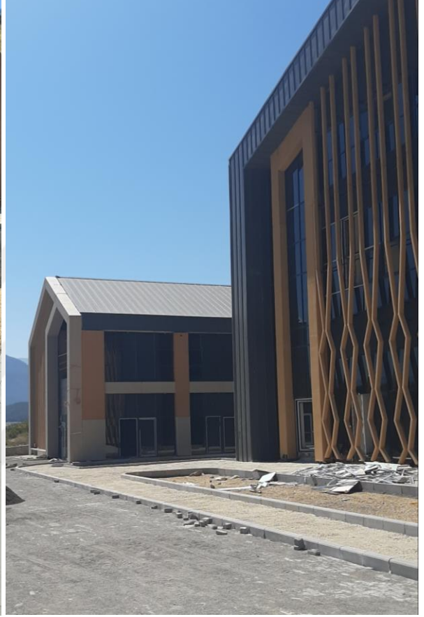
b) Atölye binası-garaj binası önü
