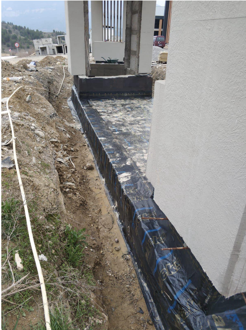
Şekil 3.19. Giriş tagı temel yalıtımı imalatından bir görünüm.
