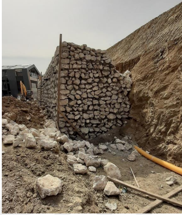
Şekil 3.20. Arka cephede yapımına başlanılan taş duvar imalatının görünümü.
