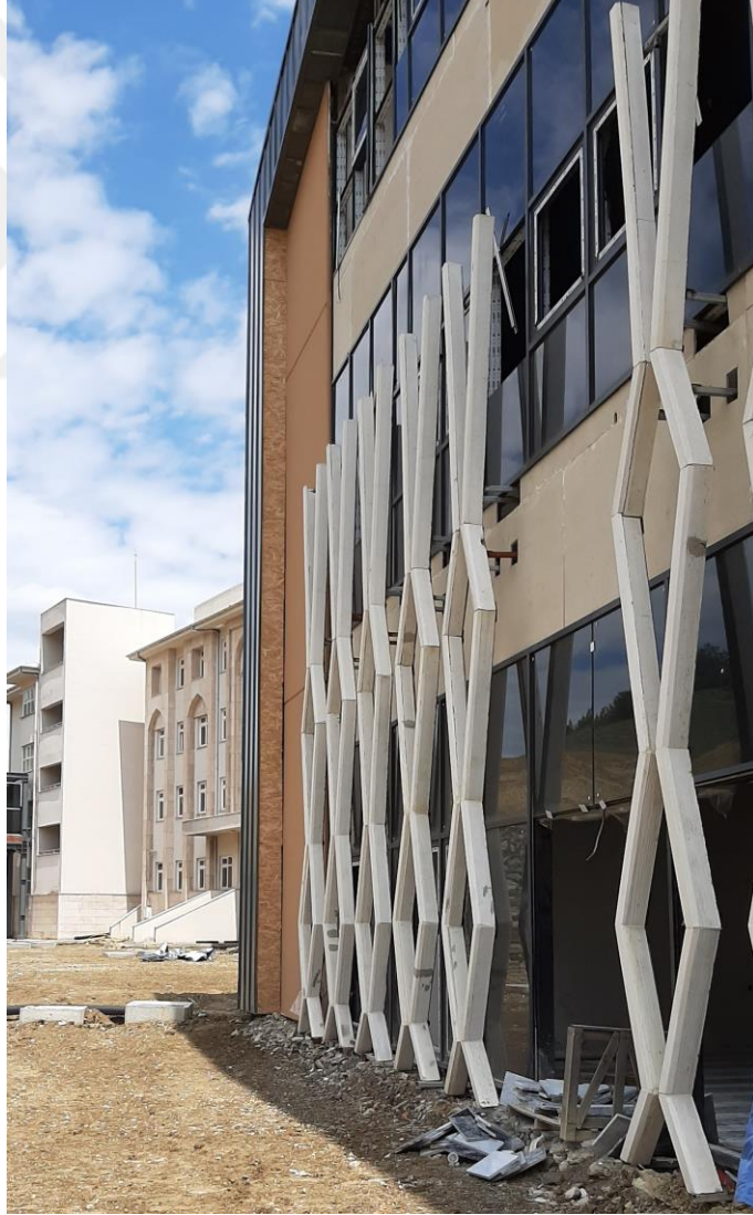
Şekil 3.28. İlk yüklenici tarafından yarım bırakılan mesh süs imalatı ve alüminyum kompozit kapatmaları.
