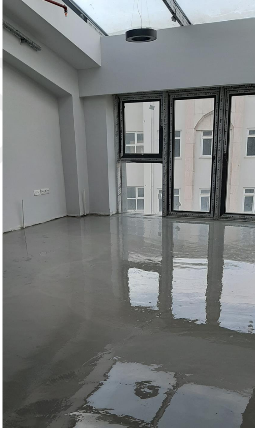
Şekil 3.35. Atölye binası odaları zemininde self leveling imalatı.
