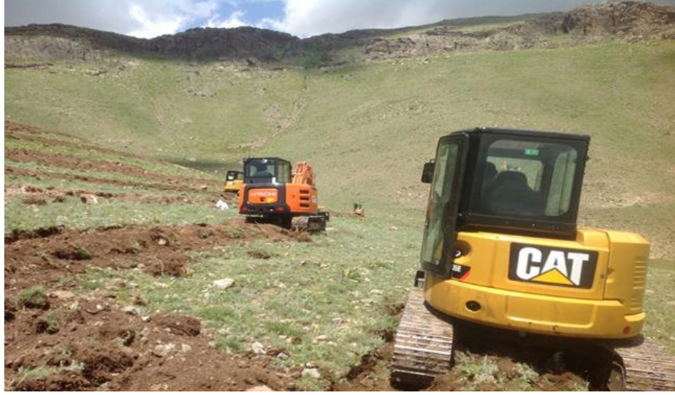
Şekil 3.13 Mini Ekskavatör ile toprak işleme
