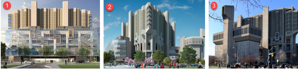
Resim 4. Robarts Kütüphanesi Ek Binası
