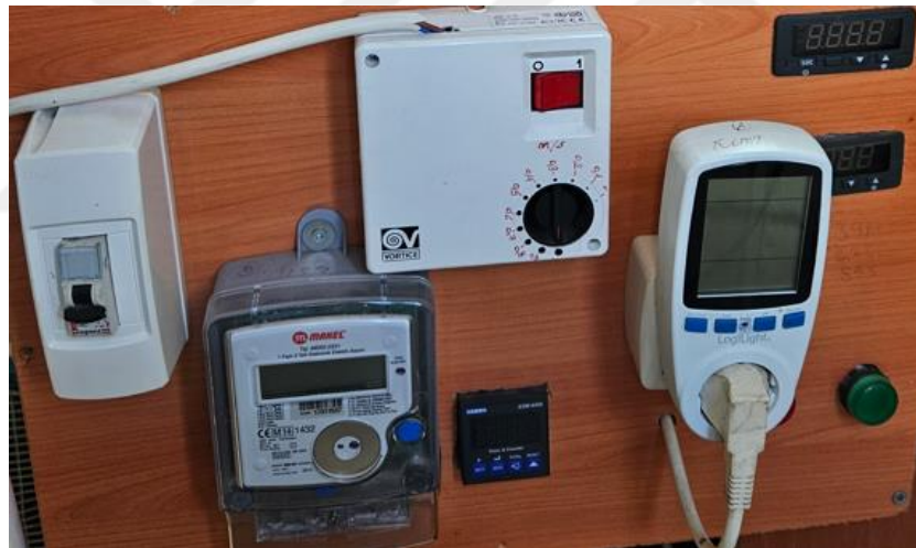
Şekil 4.10 Isı pompalı kurutucunun enerji ölçüm ve hız kontrol ekipmanları
