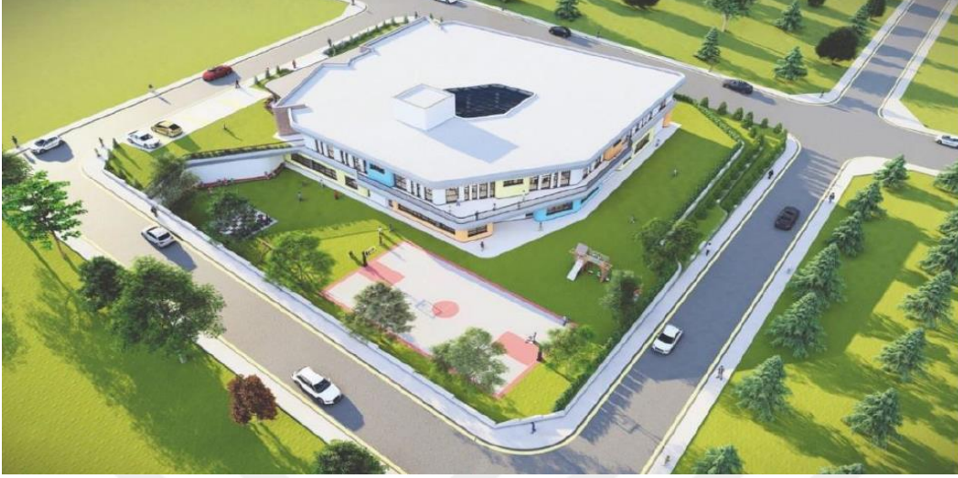
Resim 4.2. Altındağ Belediyesi Engelsiz Yaşam Merkezi
