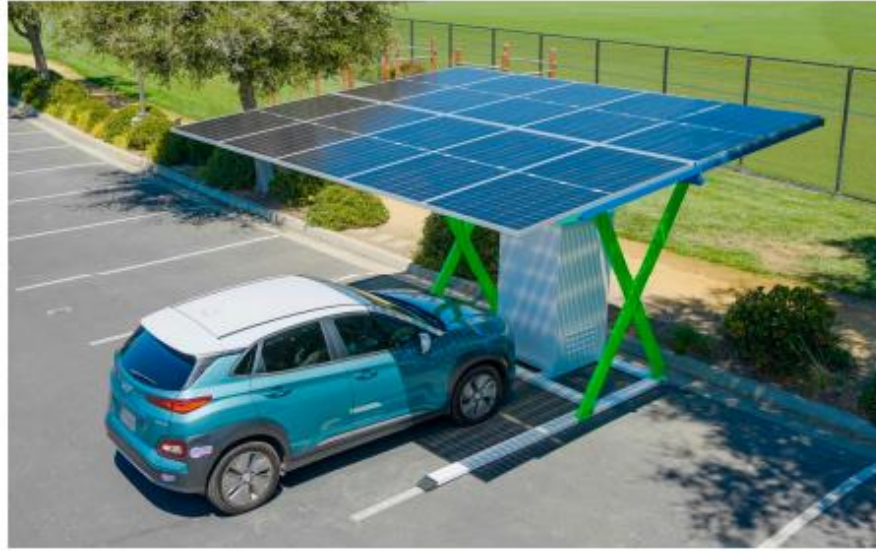
Şekil 5.4. Otoparkta PV solar şarj istasyonu [73]
