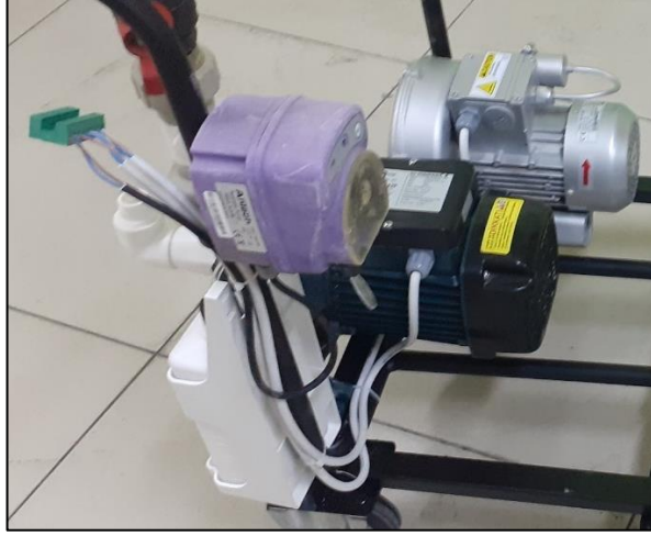
Şekil 3.20. Reaktör tarafındaki elektriksel bağlantılar ve giriş portu
