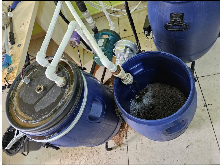
Şekil 3.34. Devirdaim hattının temizlenmesi
