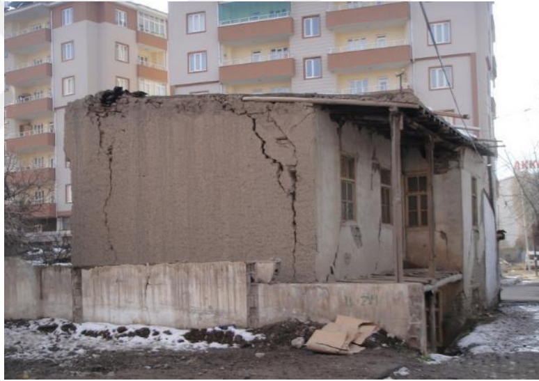
Şekil 5. 11. Düzlem dışı doğrultuda belirgin dönme görülen yığma yapı örneği (İlki vd., 2020)
