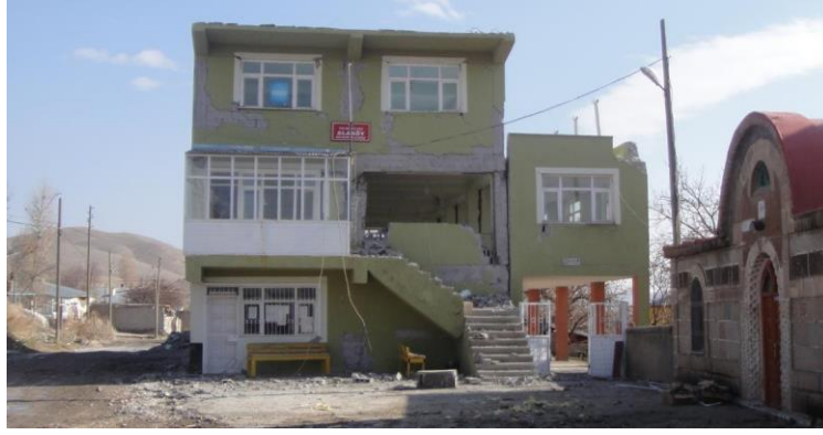
Şekil 5. 2. İnceleme katı 1. Normal kat olan betonarme yapı örneği (İlki vd., 2020)
