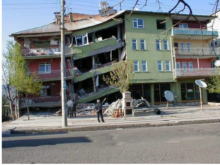
Şekil 5. 3. Bölgesel olarak göçme mekanizmasına erişen yapı örneği (İlki vd., 2020)
