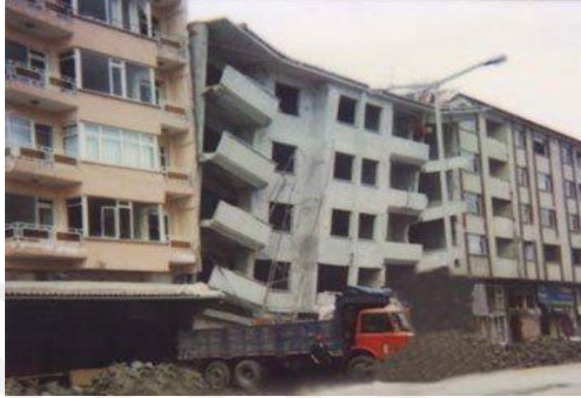
ekil 3. 29. ekileme etkisi nedeniyle yıkılmış bir bina (III) ( Anonim, 2009c )
