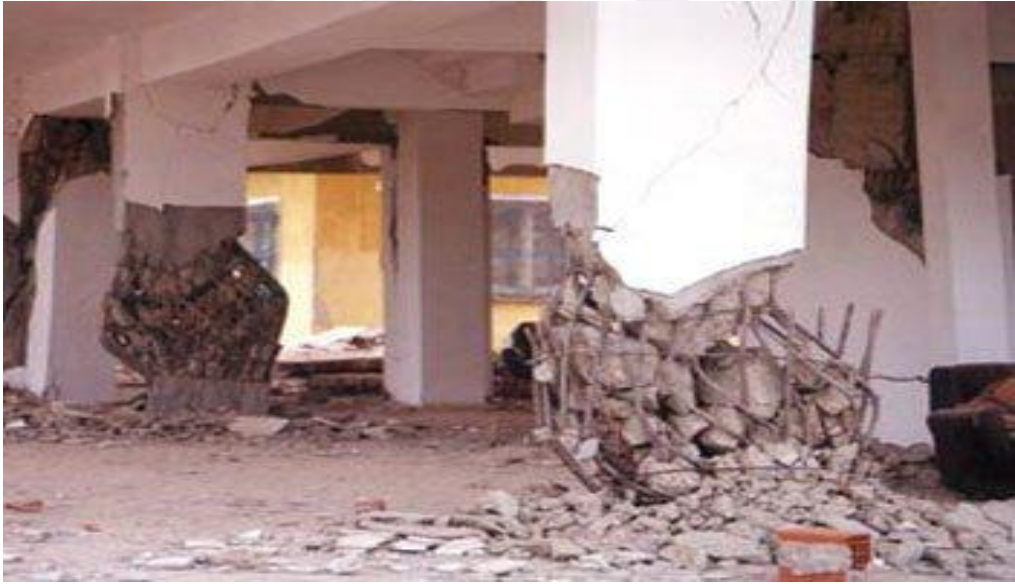
Şekil 3. 11. Yetersiz enine donatı detayı ve torsiyon kuvveti etkisinde kalmış kolonlar (Anonim, 2009c)
