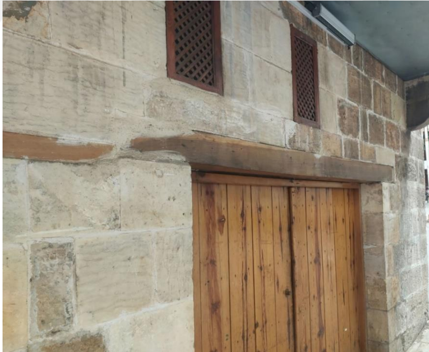
Şekil 3. 42. Büyük açıklık boyutuna rağmen hasar almamış bir duvar (Güleç, 2023)
