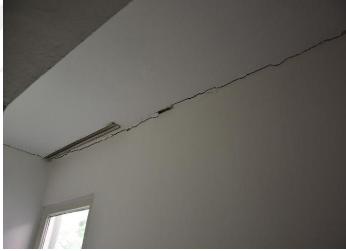
Şekil 3. 41. Bölme duvar asma tavan ayrılması ( İlki vd., 2020 )
