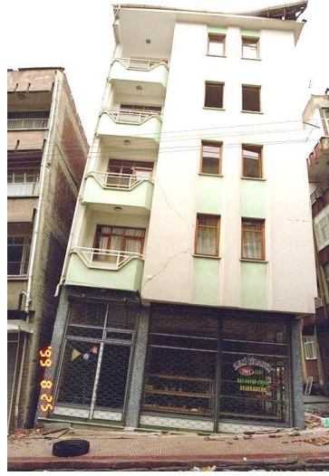
Şekil 5. 5. Temeldeki farklı oturmalar nedeni ile yan yatan yapı örneği (İlki vd., 2020)
