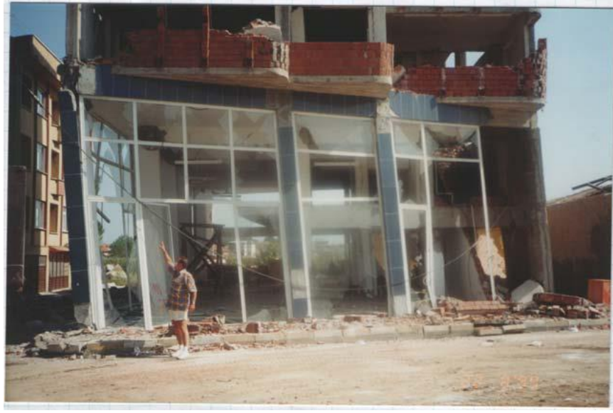
Şekil 3. 16. Zayıf kat hasarı (Tezcan vd., 2007)
