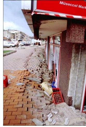
Şekil 5. 5. Temeldeki farklı oturmalar nedeni ile yan yatan yapı örneği (İlki vd., 2020)
