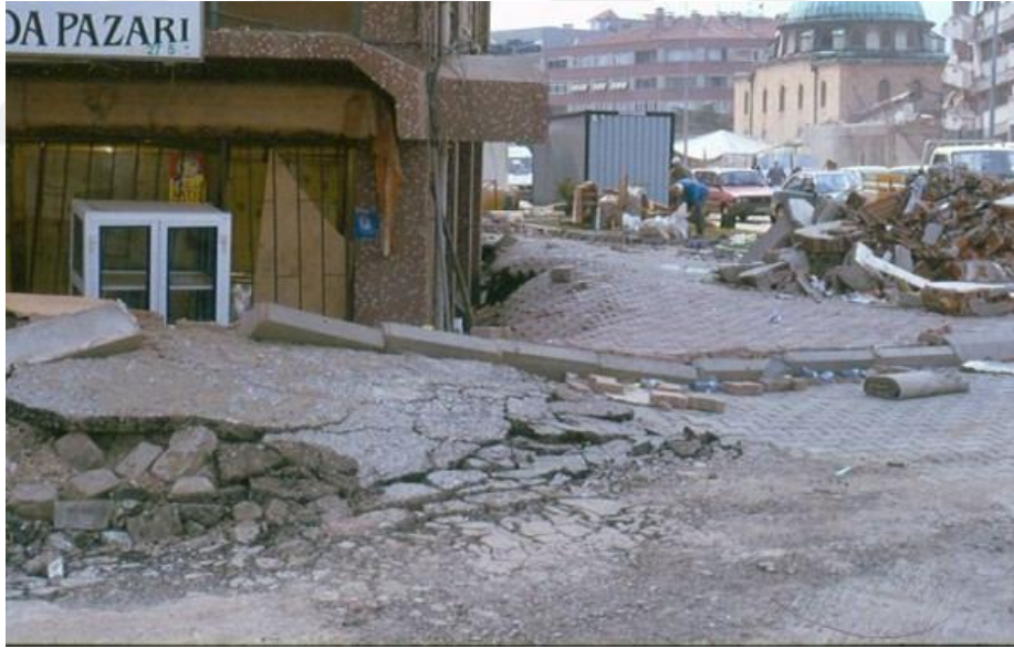
Şekil 3. 21. Zemin sıvılaşmasına örnek (Atay, 2010)
