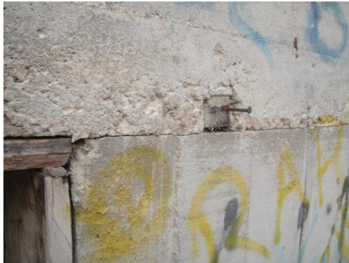
Şekil 3. 44. Soğuk derz örneği (İlki vd., 2020)
