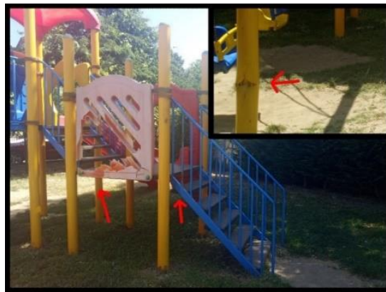
Şekil 3.20. Konuralp Anaokulu Hasarlı Oyun Elemanı (Orijinal, 2024).
