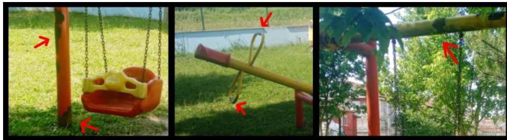
Şekil 3.26. Mevlüde Çıtlak Anaokulu Oyun Parkı İskelet Sistemi Hasarları (Orijinal, 2024).
