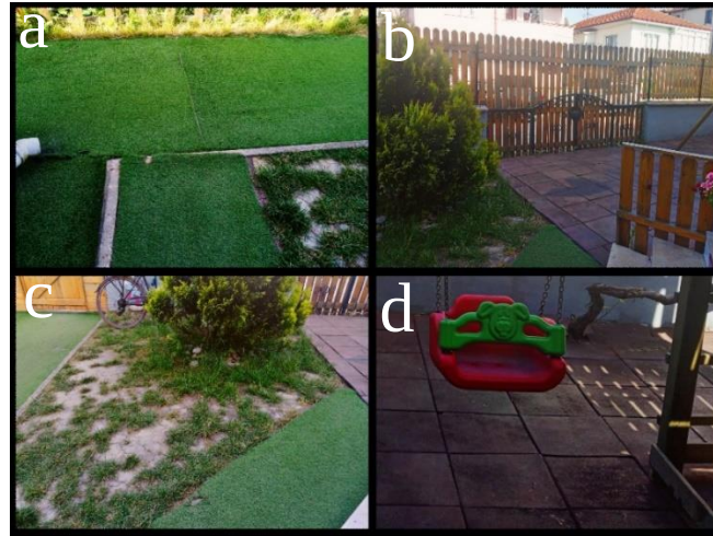
Şekil 3.28. Düzcce Özel İnci Yıldız Anaokulunun Sert Zemin Döşeme (a: çim halı yanlış uygulama, b: hatalı döşeme geçişi, c: bakımsız çim yüzey, d: bakımsız kauçuk zemin) (Orijinal, 2024).
