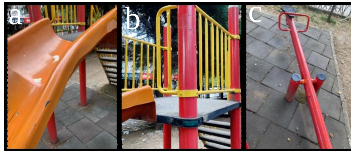
Şekil 3.37. Şükran Öney Anaokulu Hasarlı Oyun Elemanları (a: kaydırak, b: oyun parkı iskeleti, c: tahterevalli) (Orijinal, 2024).
