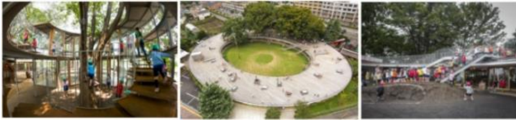
Şekil 1.15. Fuji Anaokulu Oval Çatısı, Merdiven ve Kaydırak Tasarımları (FujiKids, 2024).
