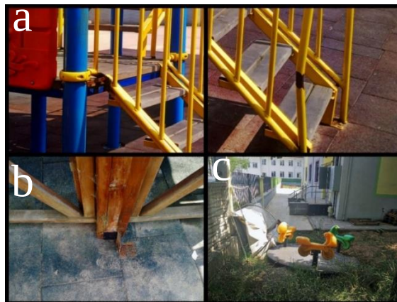
Őekil 3.7. Cevat Şahin Anaokulu Oyun Alanında Bulunan Riskler (a: oyun parkı korkulukları, b:  ardak baęlantı noktası, c: sallanan oyuncak) (Orijinal, 2024).
