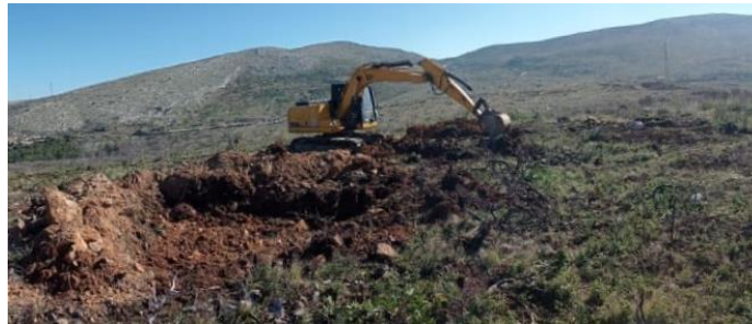
Şekil 2.4: V-Şekilli mikrohavza yapımı
