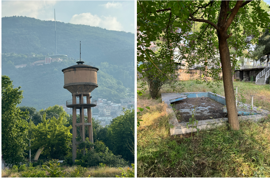
Şekil 4.6. İpekiş Fabrika alanındaki su kulesi ve süs havuzu (Dinar, 2024)
