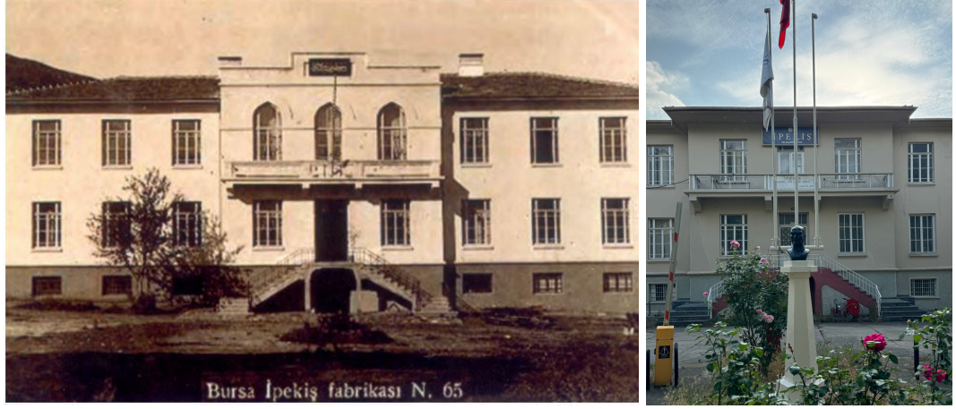
Şekil 4.4. Bursa İpekış Fabrikası idari binası (Özdemir Bircan ve Dalkılıç, 2018, Dinar, 2024)
