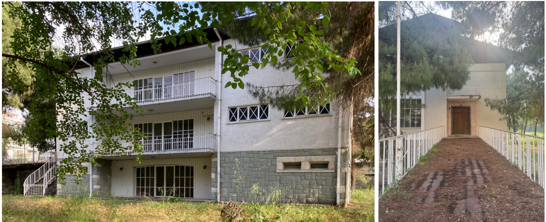
Şekil 4.5. İpekış Fabrikası lojman yapısı (Dinar, 2024)
