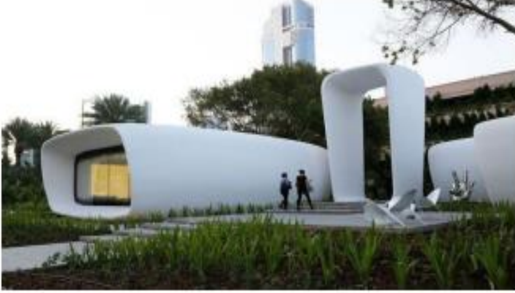
Şekil 3. 16. Üç boyutlu beton baskı ile basılan ofis binası, Dubai, 2016 (Ferro, 2016)
