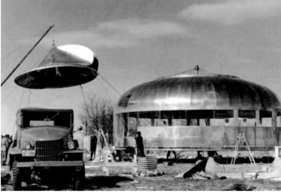
Şekil 2. 8. Dymaxion Evi montaj fotoğrafı (Gössel & Leuthauser, 2005)
