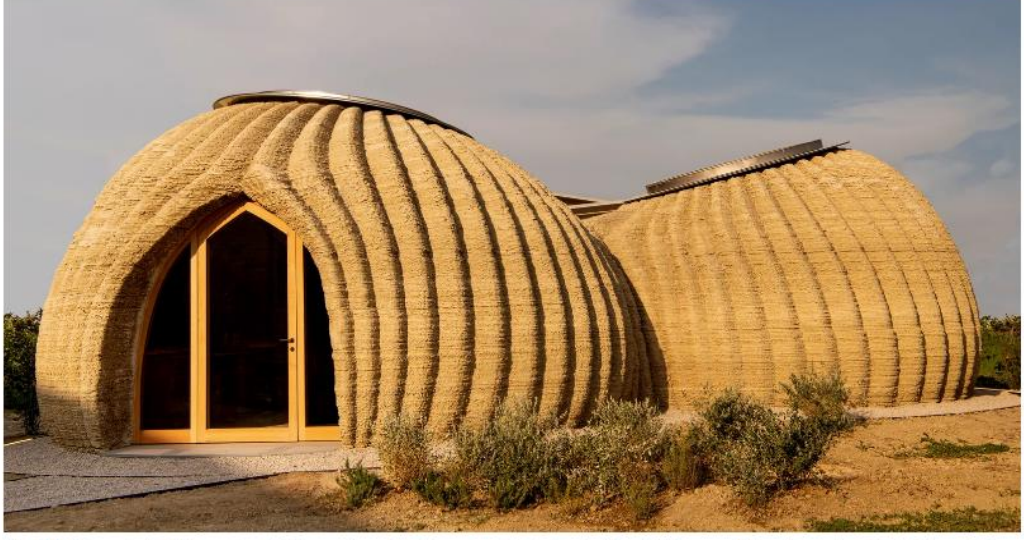
Şekil 3. 17. Üç boyutlu yazıcı ile basılmış toprak ev, 2021 (Url-26)
