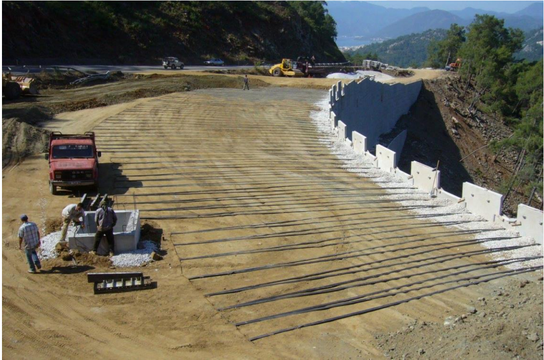
Şekil 2.29. Donatılı zemin dolgusunda donatıların yerleştirilmesi.
