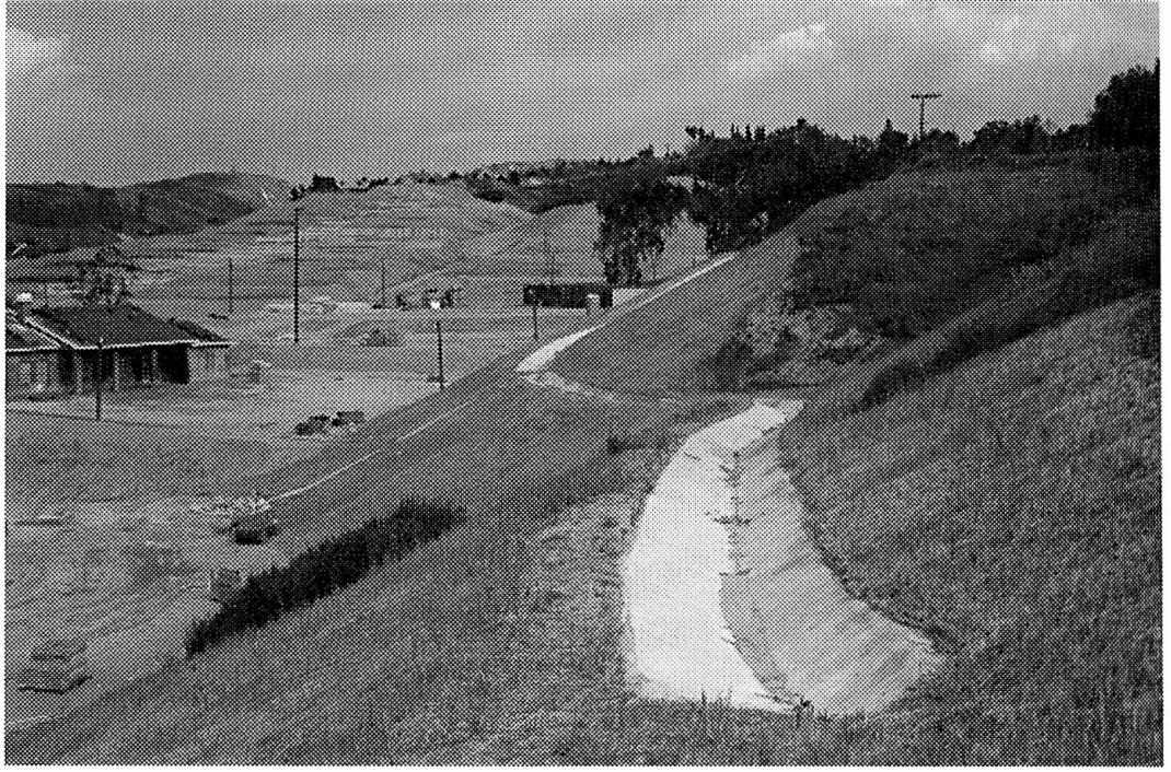
Şekil 2.21. Bir yarma şevinde tipik yüzey drenajı beton hendek [22].
