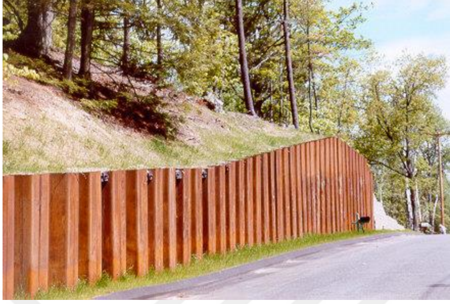
Şekil 2.38. Palplanş perde uygulaması.
