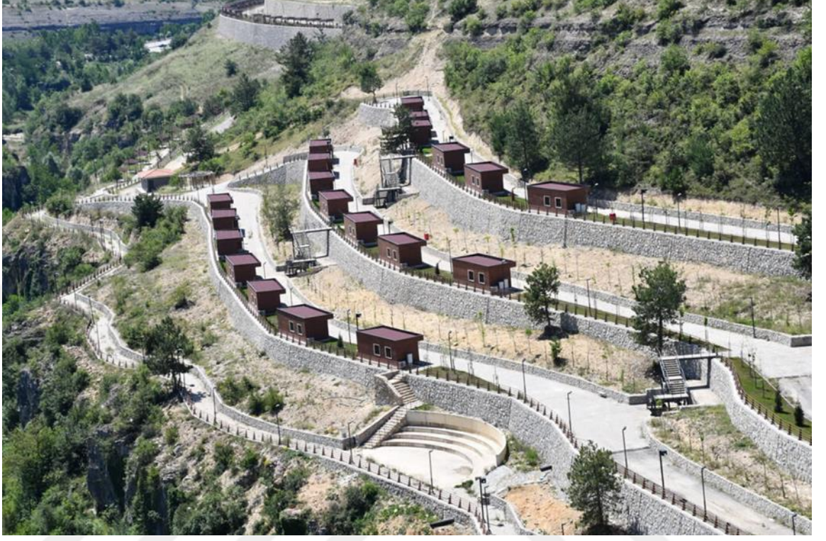
Şekil 2.24. Kademelendirme ve taş duvarın birlikte kullanıldığı şev stabilizasyonu.
