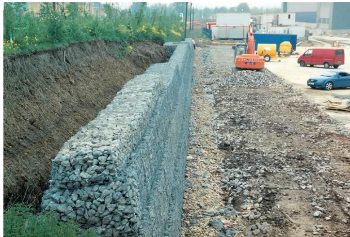
Şekil 2.31. Sandık (gabion) duvar uygulaması.
