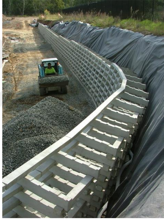
Şekil 2.32. Kafes duvar uygulaması.
