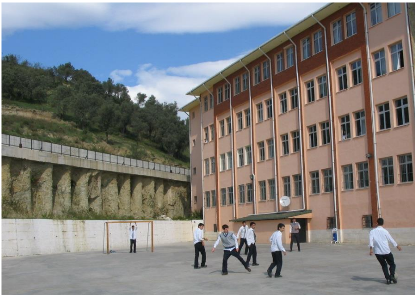
Şekil 2.34. Fore kazık uygulaması ile şev stabilizasyonu.
