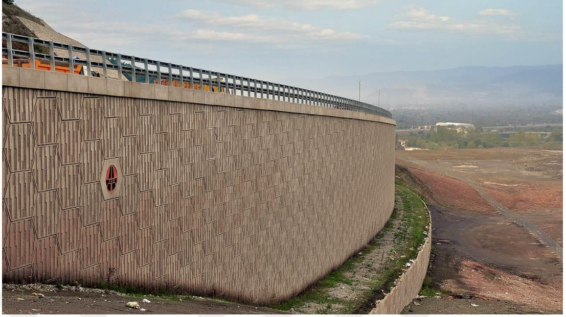
Şekil 2.30. Şevde donatılı zemin uygulaması.
