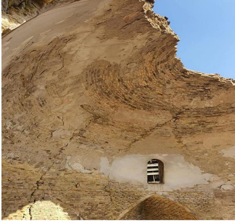
Fotograf 69: Paşa hamamı'nın durumu
