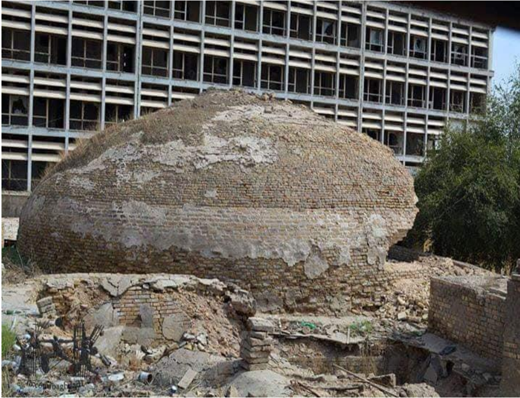
Fotograf 67: Paşa hamamı'nın durumu
