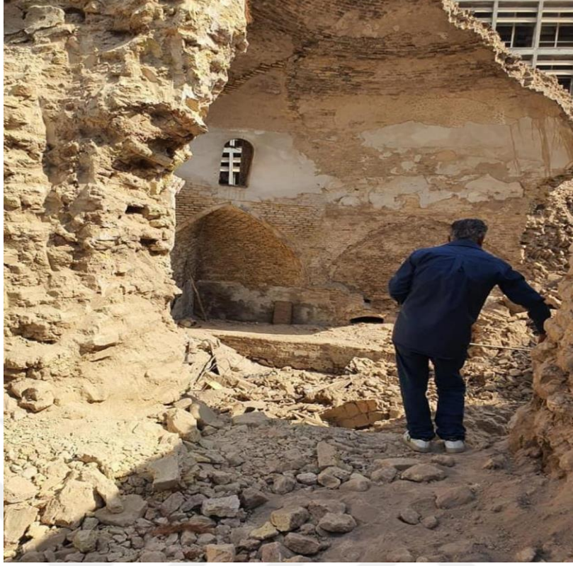
Fotograf 68: Paşa hamamı'nın durumu
