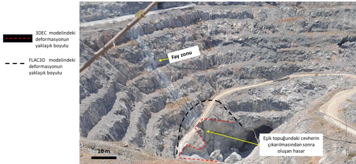
Şekil 5.30. Sahadaki deformasyonun boyutunun FLAC3D ve 3DEC'de tahmin edilen yenilme ile karşılaştırılması
