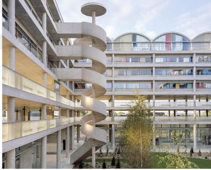
Görsel 17. Student Housing, Paris, Strüktürel dış iskeletle kurgulanan yapı değişen ihtiyaçlara göre doldurulup boşaltılabilen ve farklı fonksiyonla hizmet edebilen bir esneklik sunmaktadır.
