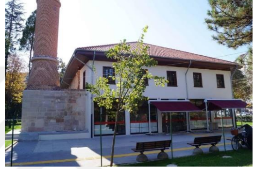
d. Restorasyon sonrası kuzey cephesi
