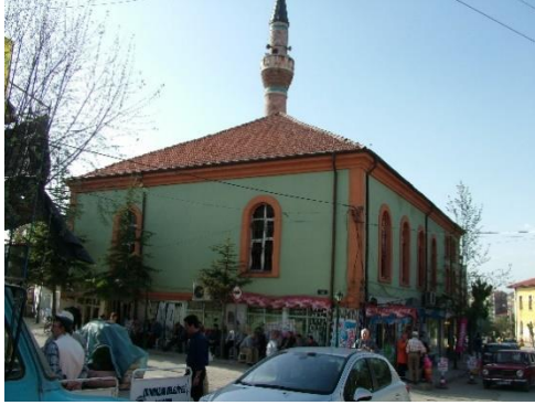
a. Raspa öncesi cami cephesi
