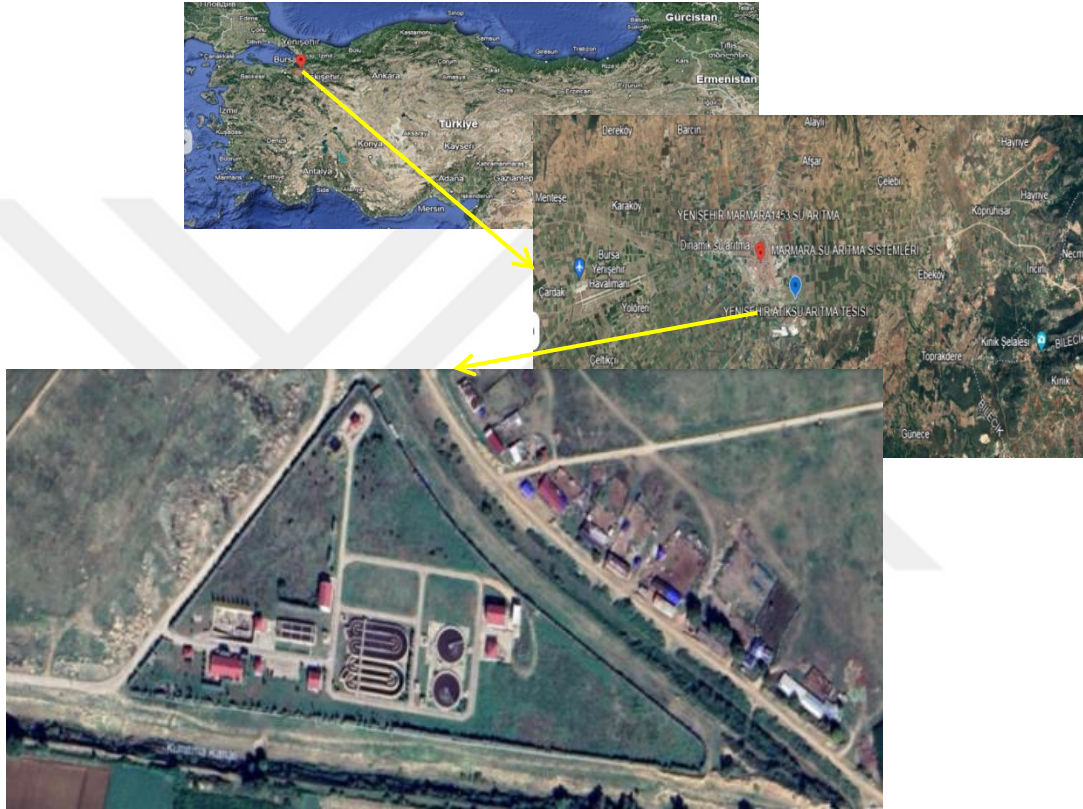
Şekil 5.3 : Yenişehir atıksu arıtma tesisi.
