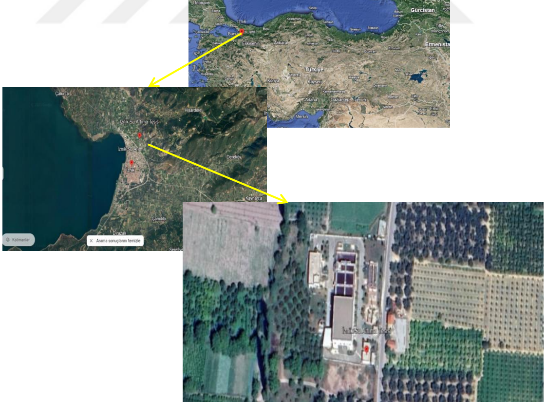
Şekil 5.1 : İznik atıksu arıtma tesisi.
