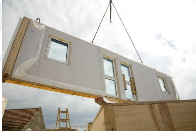
Şekil 3.14. Prefabrik duvar panel sistem. [57]
