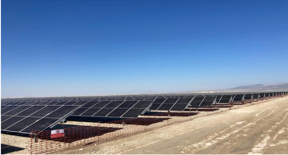
Şekil 2.1 Karapınar Güneş Enerji Santrali [14].
