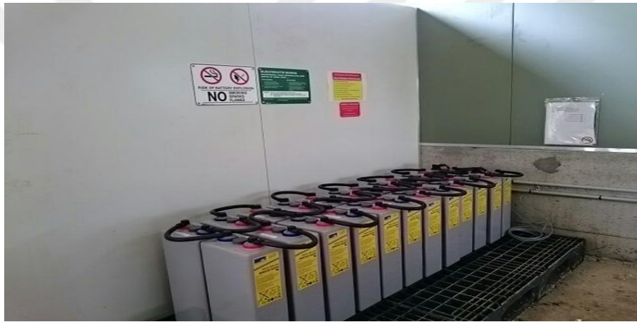
Şekil 3.13 Karayaprak tepe kullanılan jel aküler.
