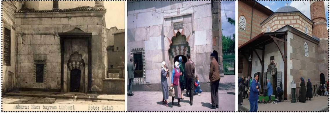
Şekil 4.54 1930’lu yıllarda Hacıbayram Veli Türbesi (sol) (Cangır 2007), 1987 yılı Hacıbayram Veli Türbesi (orta) (Gönenç 1987) ve günümüzdeki durumu (sağ)
