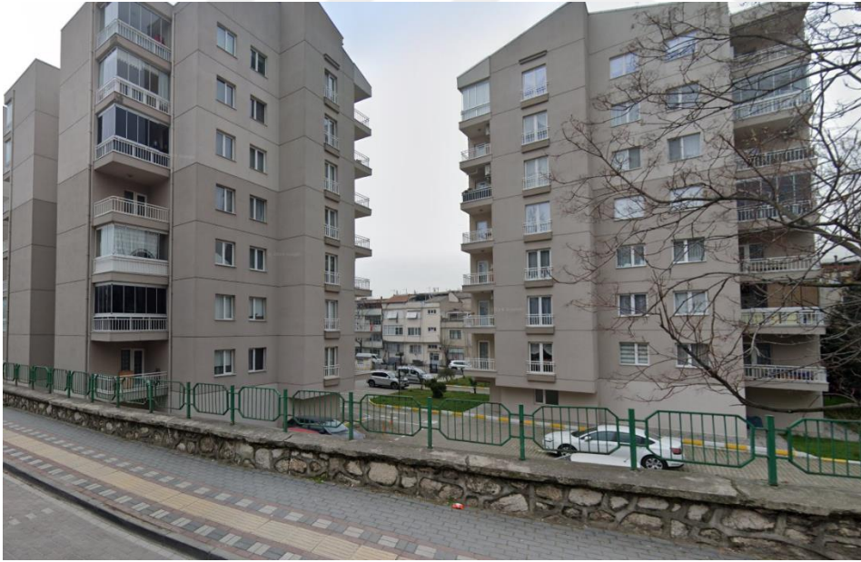
Şekil 4.1 İki apartman binası arasından görünen Karaman Mahallesi'ndeki göçmenlere ait yapılar
