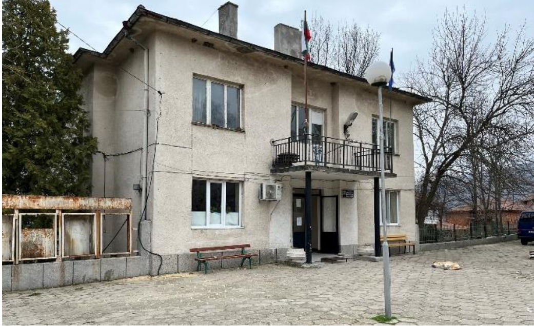
Şekil 3.14 Şiroko Pole Köyü Muhtarlık Binası, 1970'li yıllardan itibaren aktif
