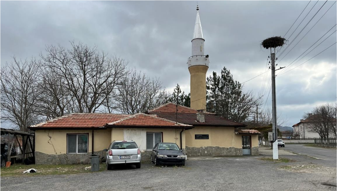
Şekil 3.7 Skalişte Köyü Camii, 1970’lerden beri kullanılan, köy merkezindeki camii
