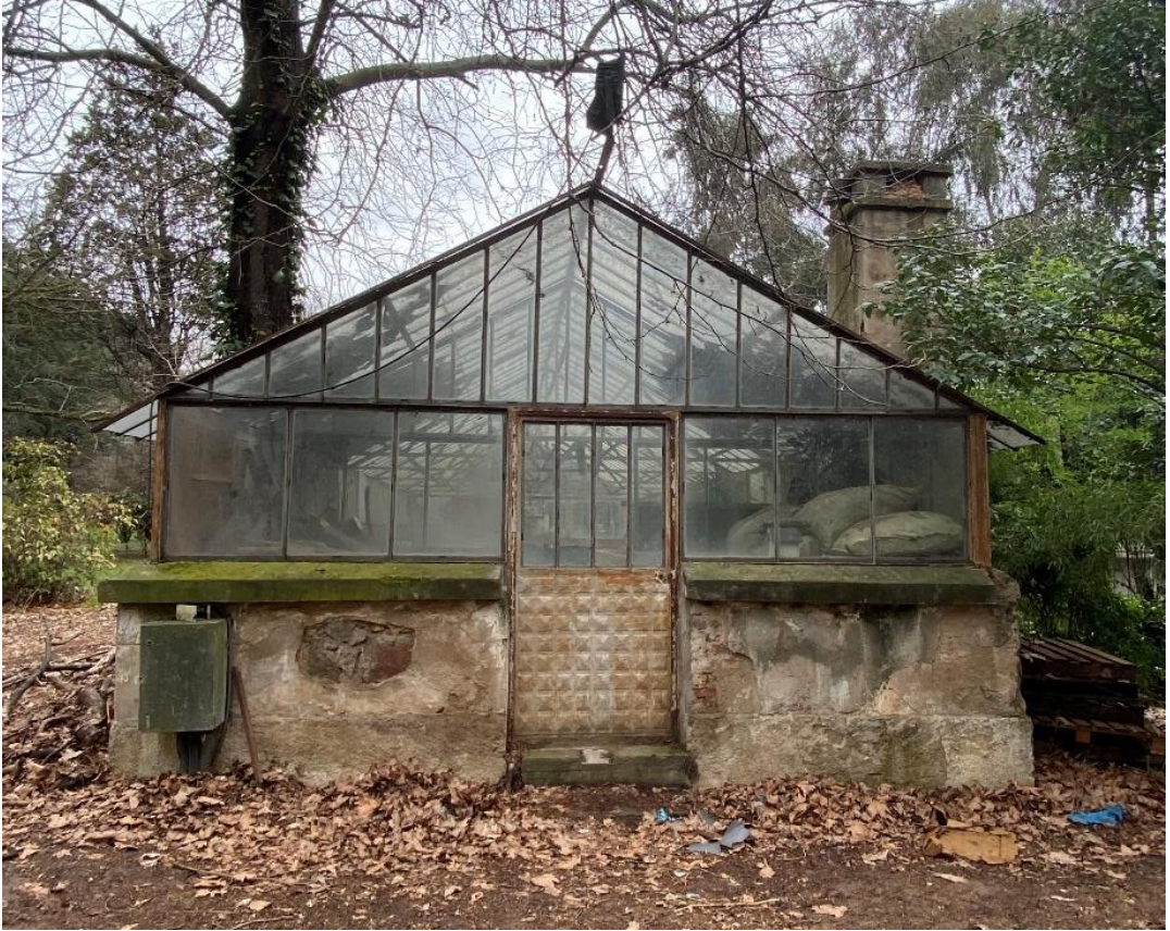
Şekil 5.7: GTÜ Eski sera güney cephesi.
