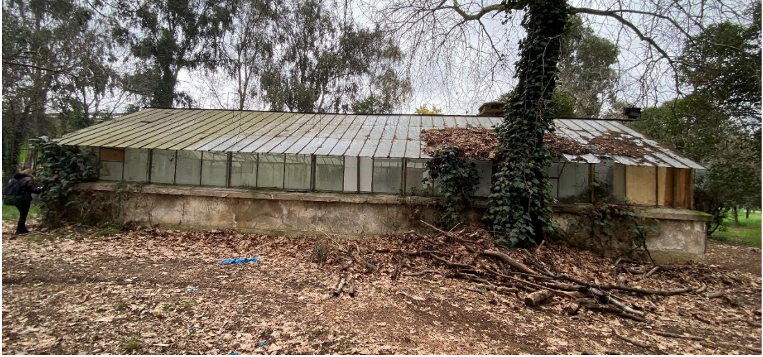
Şekil 5.11: GTÜ Eski sera batı cephesi.
