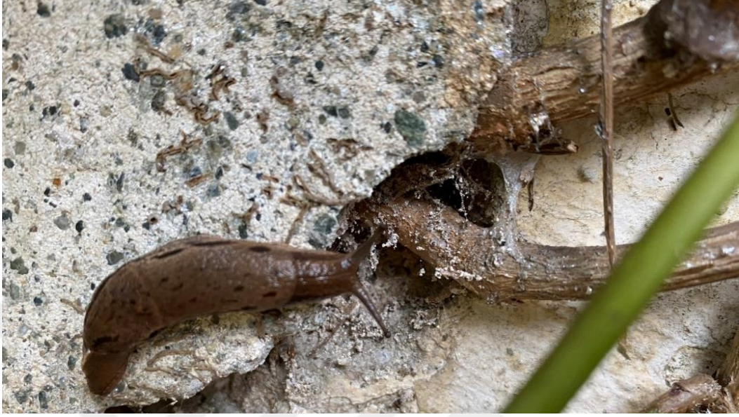
Şekil 5.21: Sarmaşık ve duvar çatlağı arasındaki etkileşim.
