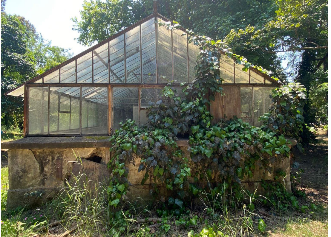
Şekil 5.5: GTÜ Eski sera kuzey cephesi.
