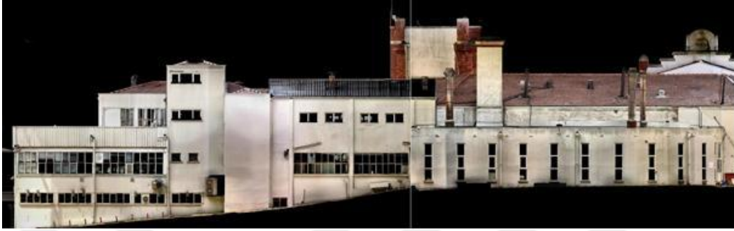
Şekil 4.45 Yıldız Çini ve Porselen Fabrikası'nın doğu cephesi [41]
