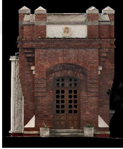
Şekil 4.44 Yıldız Çini ve Porselen Fabrikası'nın kuzey cephesi [41]
