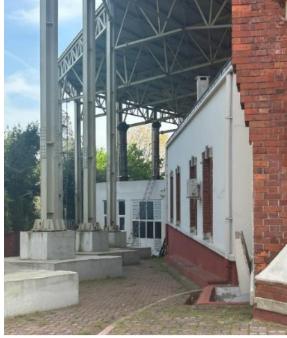
Şekil 4.54 Fabrika üzerinde bulunan çelik strüktür [41]
