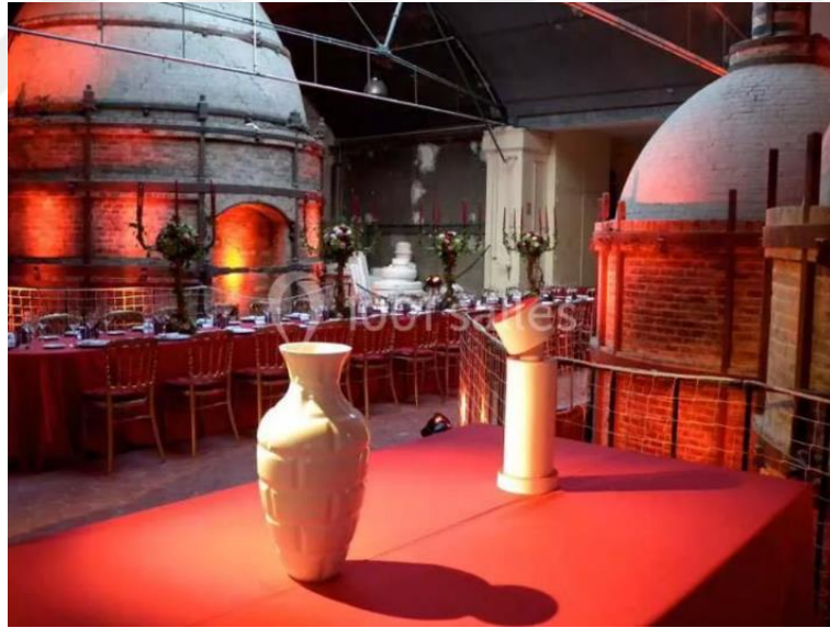
Şekil 4.69 Sevres Porselen Fabrikası'nda korunan kubbeli fırınlar [51]
