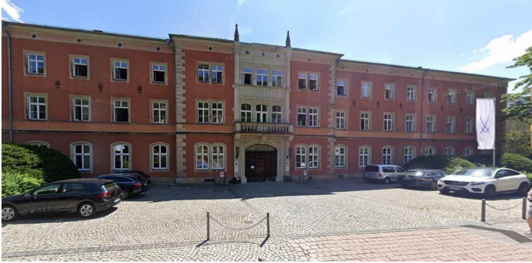
Şekil 4.77 İlk inşa edilen Meissen Porselen Müzesi [58]
