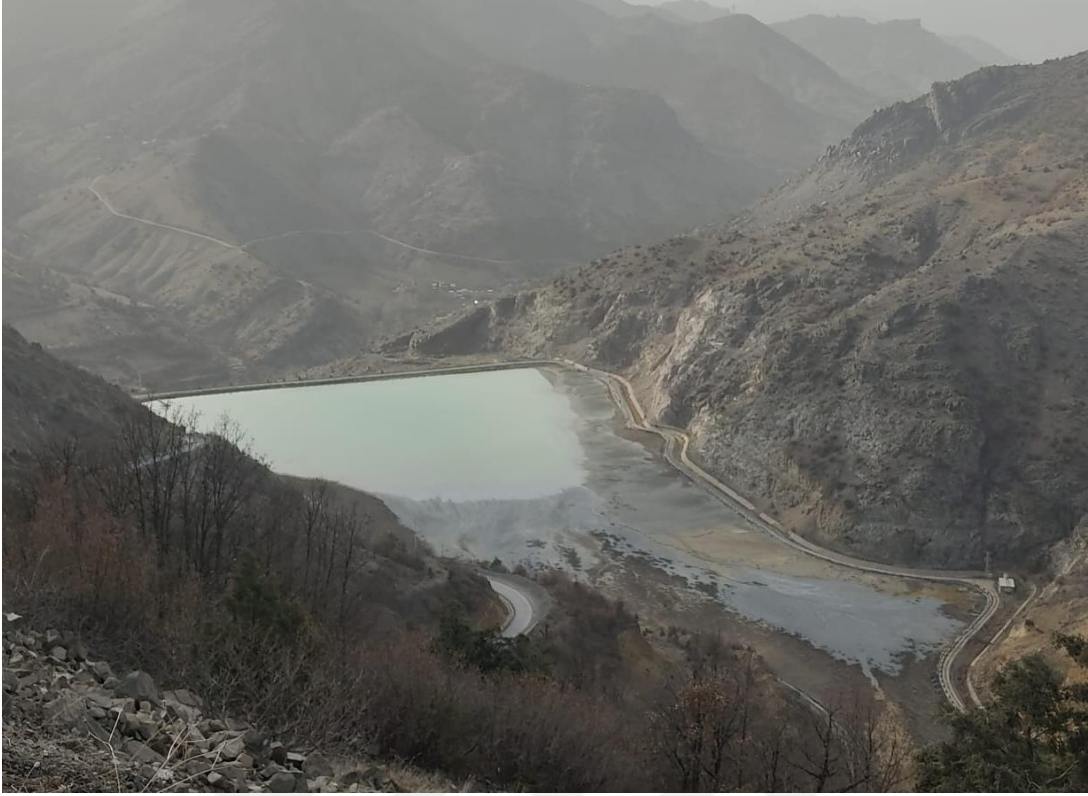
Fotoğraf 25: Gümüşhane Merkez Demirkaynak Köyü (Mastra) altın madeni atık barajı
