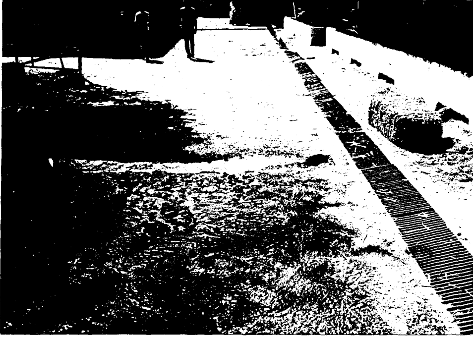
RESİM 4.12. İşletme Avlusu İçerisinde Uygun Şekilde Projelenmiş Ancak Çalışmayan Bir Boşaltım Sistemi
