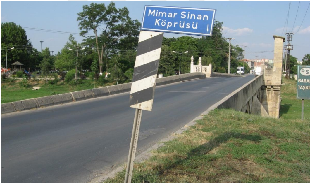
Şekil 4.10 Dolgu ve asfalt uygulamalarıyla köprü üst kotunun yükselmesi korkuluk yüksekliklerinden izlenebilmektedir. Babaeski Köprüsü, Babaeski, Kırklareli (Pınar Gök,2008).
