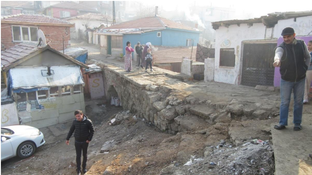
Şekil 4.20 Muradiye Mahallesi'nde yer alan taş köprüye komşu yapılaşmalar, Edirne, Merkez ilçesi (Pınar Gök, 2017).
