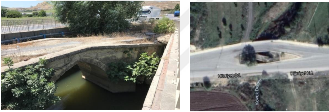
Şekil 4.16 (a) Memba ve mansap tarafına yapılan köprülerin arasında kalan Enverpaşa (Gökçeli) Köprüsü, Çatalca, İstanbul (Pınar Gök,2020). (b) Hava fotoğrafı (Parsel Sorgu, 2021)
