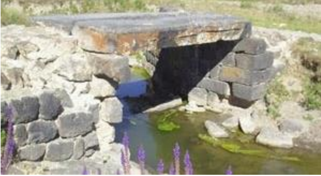
Şekil 2.4 Taşın lento olarak kullanımı. Kız Köprüsü, Malazgirt, Muş. (Kız Köprüsü, 2013)
