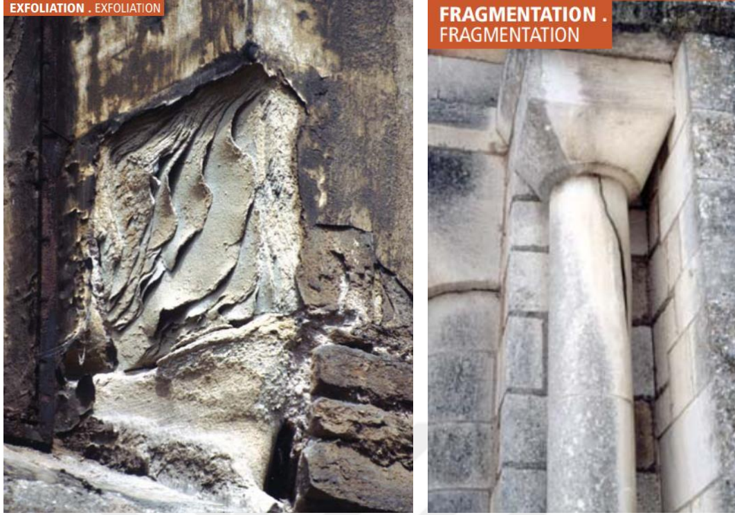
Şekil 4.27 (a) Yapraklanma (exfoliation) (ICOMOS, 2008, s.19) (b) Parçalanma (fragmentation) (ICOMOS, 2008, s.23)
