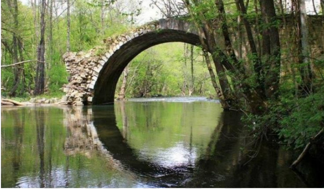
Şekil 4.26 Volcan Köprüsü, Kırklareli-Bulgaristan Sınırı (Volcan Köprüsü, 2017)
