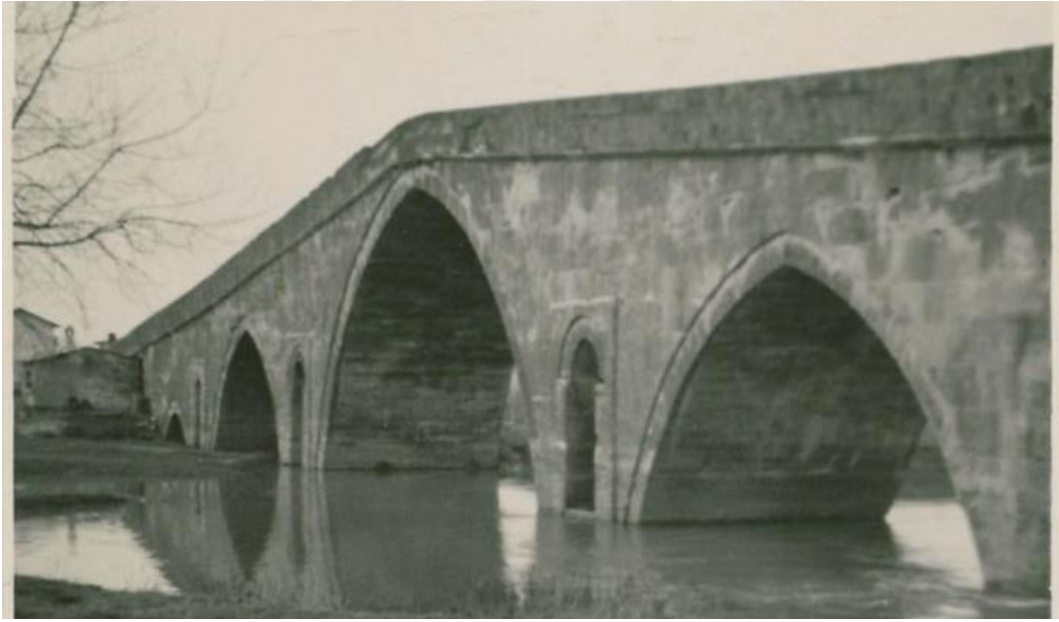
Şekil 2.5 20 m genişliğinde açıklığın sadece 75 cm kalınlığında sivri kemerle geçildiği Sinanlı Köprüsü. (Sınanlı Köprüsü, 2018)
