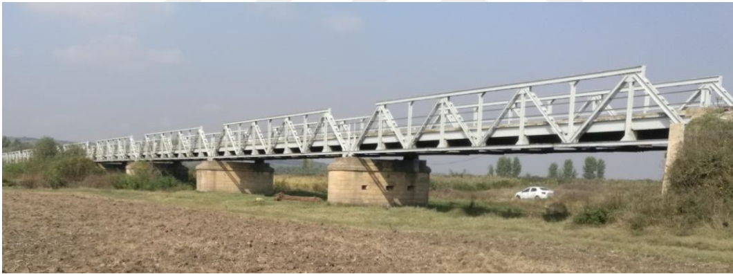
Şekil 2.7 Dikmeli warren makaslı Nafia Köprüsü (1912), Uzunköprü, Edirne
