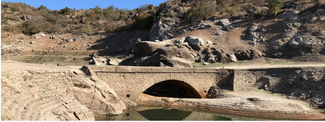
Şekil 4.25 Kırklareli ili, Demirköy ilçesinde baraj gölü altında kalan Çağlayan Köprüsü suların çekilmesi nedeniyle ortaya çıkmıştır (Pınar Gök, 2023).
