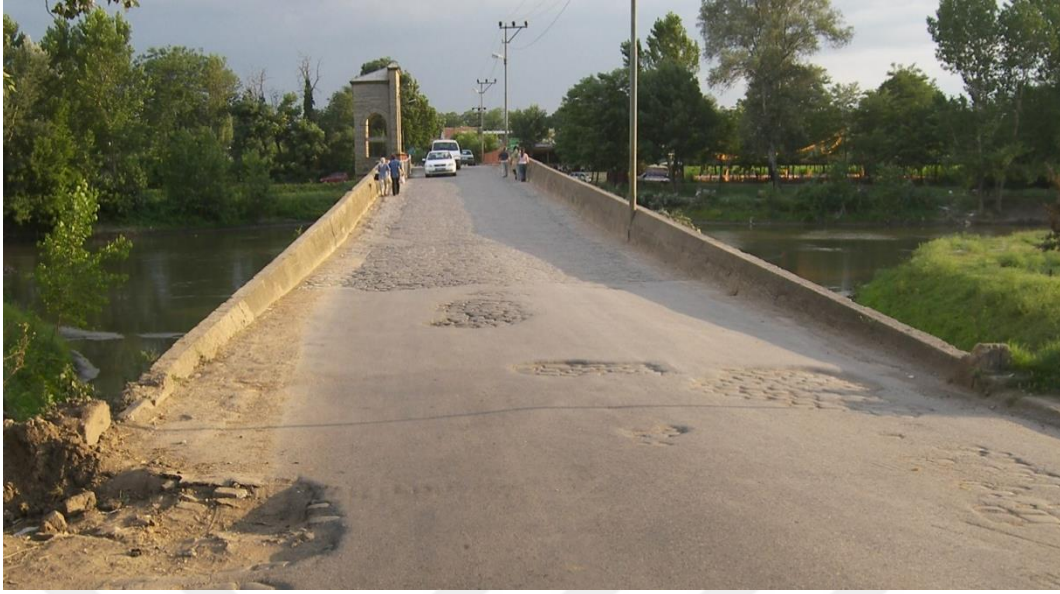
Şekil 4.9 Dolgu, taş parke ve asfalt uygulamalarıyla köprü üst kotunun yükselmesi korkuluk yüksekliklerinden izlenebilmektedir. Tunca Köprüsü, Edirne (Cemil Özer, 2007).
