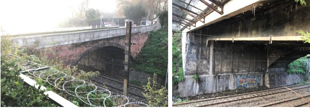
Şekil 4.17 (a) Tarihi demiryolu köprüsü, İstanbul, Fatih (b) Tarihi köprünün doğu cephesine bitişik inşa edilen betonarme köprü (Pınar Gök, 2020).
