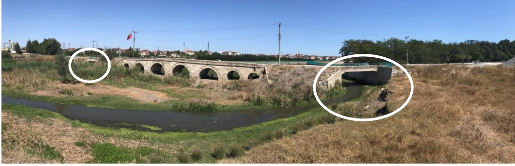
Şekil 4.21 Büyükkarıştıran Köprüsü debuşesini arttırmak için yapılan menfezler. Kırklareli, Büyükkarıştıran (Pınar Gök, 2020).
