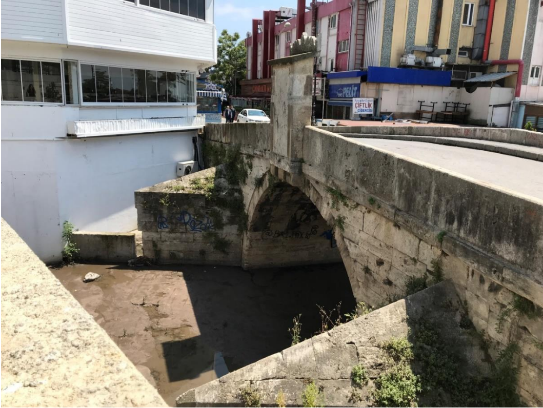
Şekil 4.18 Bostancı Köprüsü memba tarafına yapılan bina, İstanbul, Bostancı (Pınar Gök, 2020).
