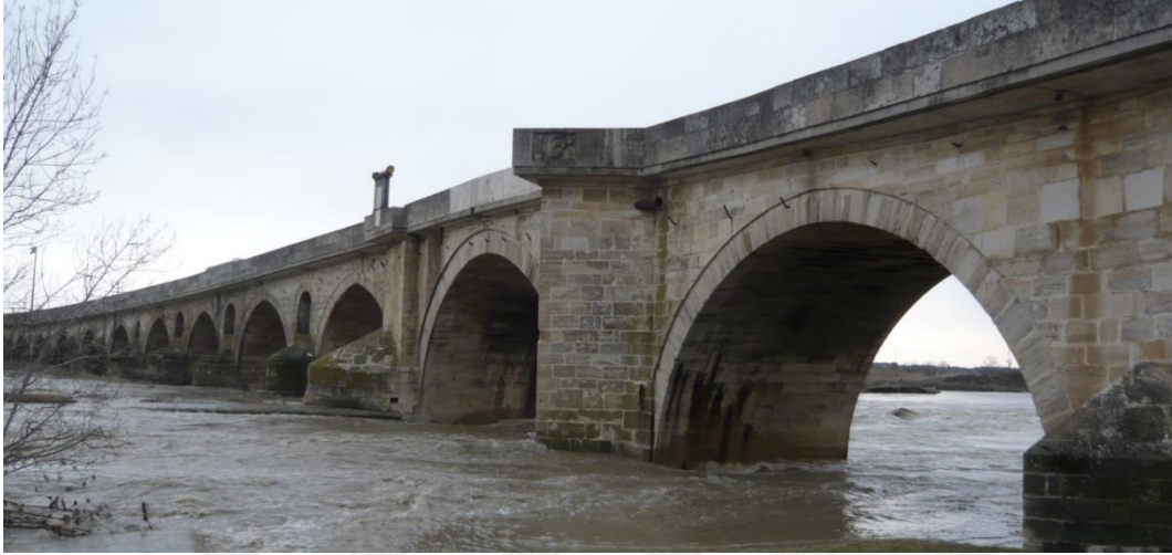
Şekil 4.11 Uzunköprü üzerindeki betonarme, Edirne, Uzunköprü (Pınar Gök, 2012)
