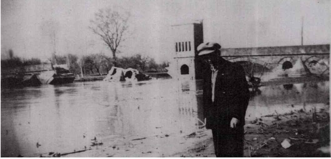
Şekil 4.31 Ekmekçizade Ahmet Paşa Köprüsü, Edirne (Türkmenoğlu, 2012, s.61)
