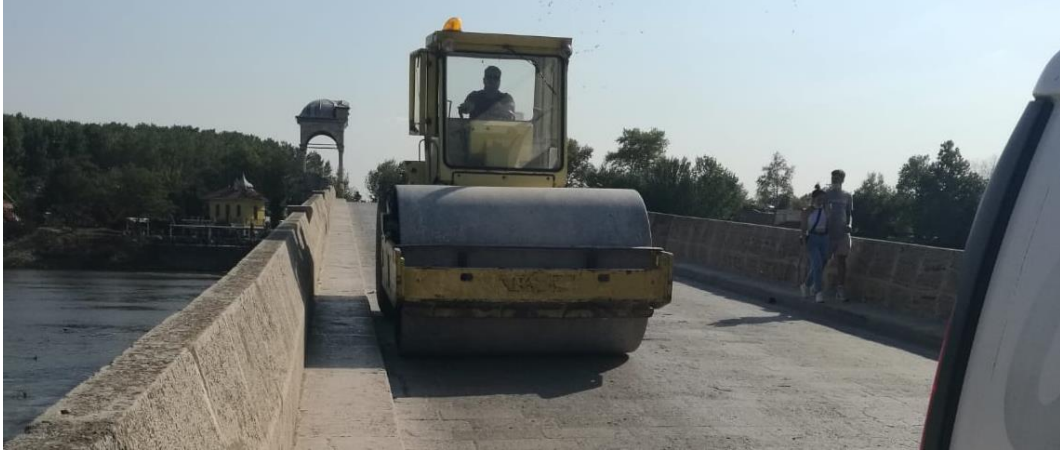
Şekil 4.5 Mecidiye (Meriç) Köprüsü üzerinden ağır vasıta geçişi. Edirne ili, Merkez ilçesi (Himmet Türkeli, 2020)
