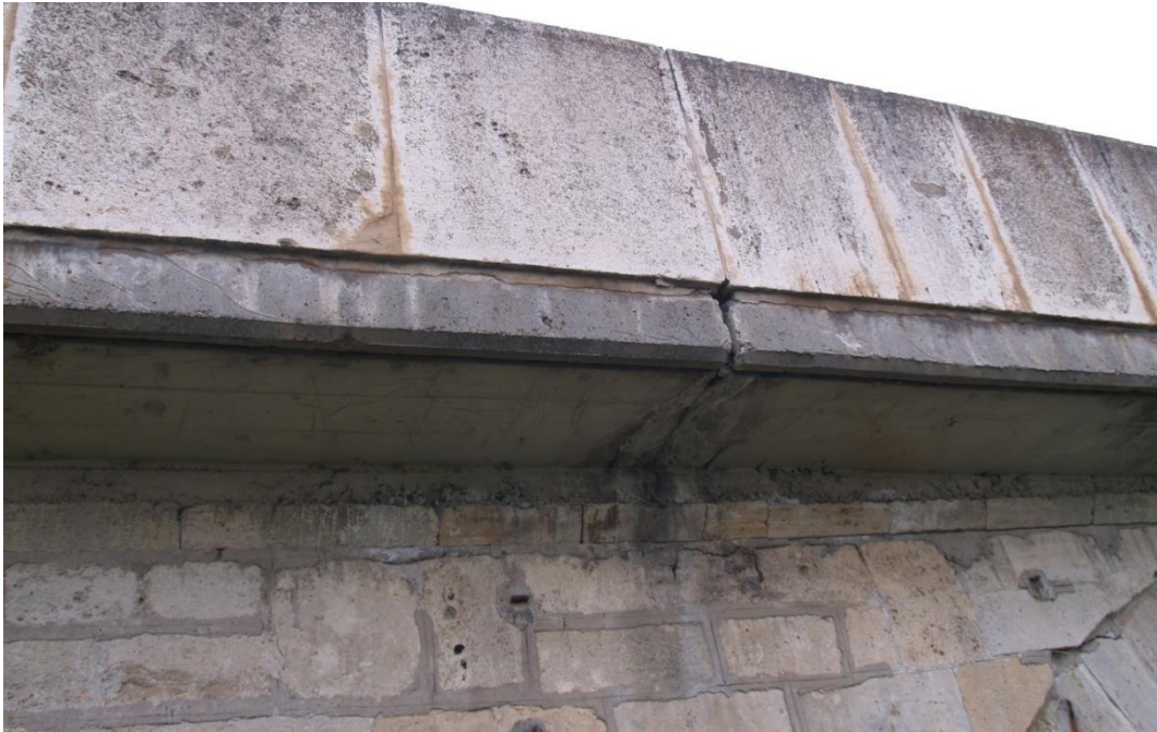
Şekil 4.12 Uzunköprü üzerindeki betonarme tabliye içerisinde kalmış korniş taşları, Edirne, Uzunköprü (Pınar Gök, 2006).
