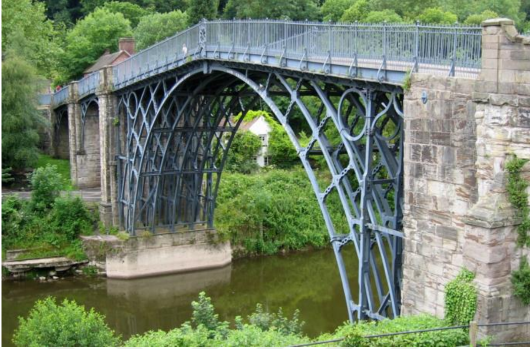
Şekil 2.6 Kemer formunda tasarlanmış dökme demir The Iron Bridge, Shropshire, İngiltere. (The Iron Bridge, 2010)
