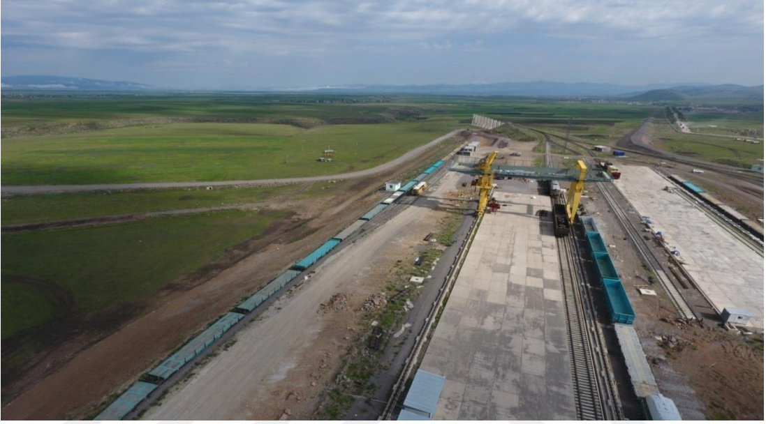
Şekil 1.3.2.3.2: Ahilkelek İstasyonu Konteyner Aktarma Yolu (VİNÇ)
