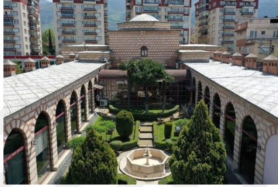
Resim 43: Bursa Yıldırım Bayezid Darüşşifası Avlu (URL-39)
