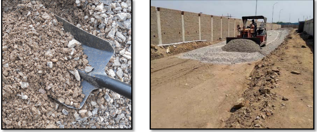
Şekil 2.4. Granüler alttemel malzemesi ve serilme işlemi ( https://pavementinteractive.org/ )
