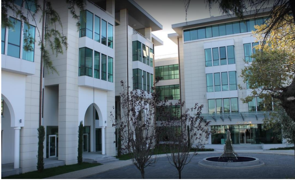
Şekil 3.32: Marmara Üniversitesi İlahiyat Fakültesi A Blok ve Dekanlık Binası Giriş Cephesi (Url-40)
