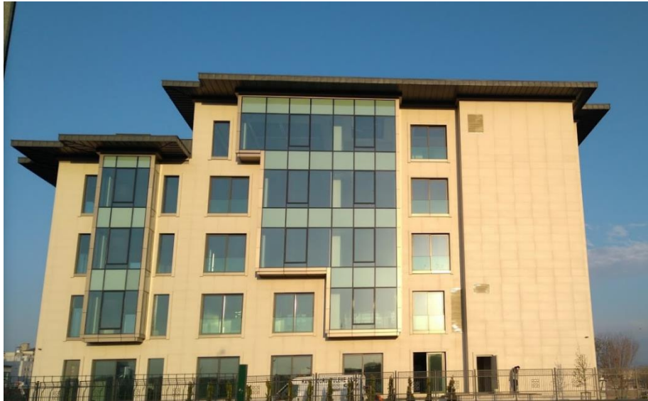
Şekil 3.20: MÜSİAD Genel Merkez Binası Yan Cephesi (Url-33)
