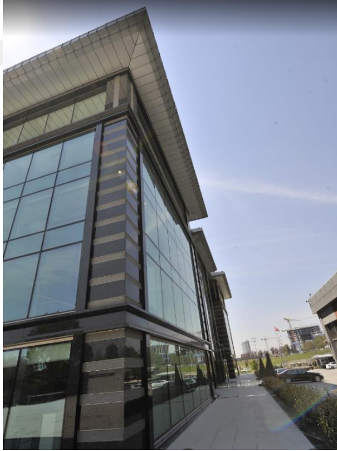
Şekil 3.10: Albayrak Holding Çatı Çıkması (Url-27)
