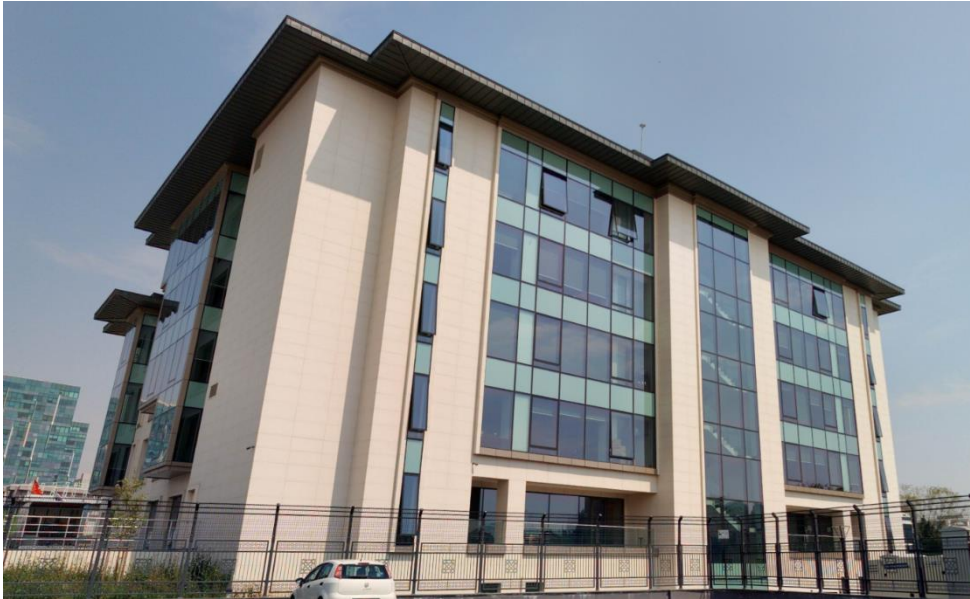
Şekil 3.21: MÜSİAD Genel Merkez Binası Arka Cephesi (Url-34)
