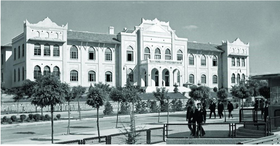
Şekil 2.35: Hariciye Vekaleti Binası (Url-16)
