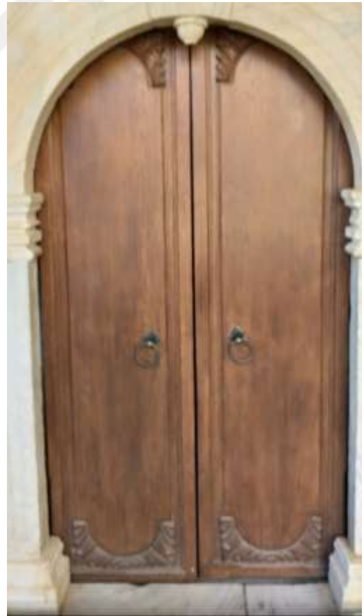
Resim 28: Kuzey cephe giriş yeni kapı, 2021.
