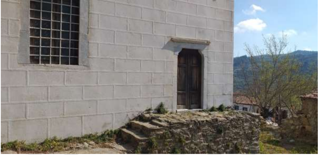
Resim 61: Güney kapı ve merdivenler, 2021.
