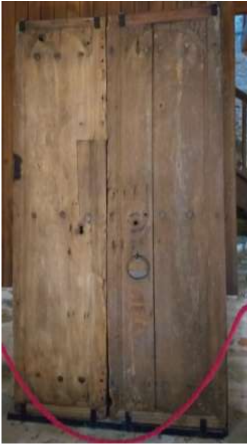
Resim 27: Kuzey cephe giriş eski kapı, 2021.
