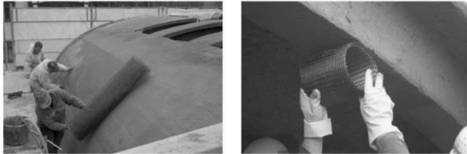
Şekil 3.7. Beton bileşenlere harici bir tekstil tabakası uygulayarak onarım ve güçlendirme
