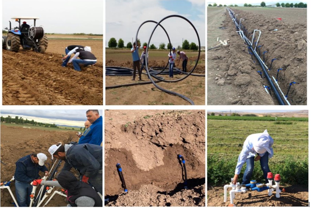
Şekil 3.4 Yüzeyaltı damla sulama sistemi kurulumuna ait görüntüler
