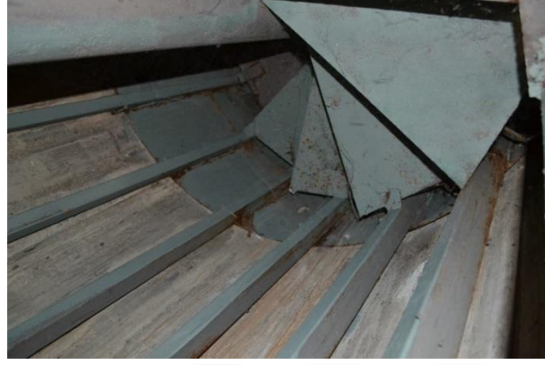
Şekil 3.6. Çelik karkas minare
