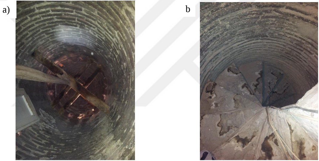
Şekil 3.3. Yığma minare a) merdiven ve b) dikme görünüşü
