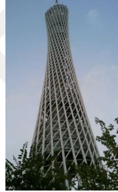
Şekil 3.20. Yapının dış diagrid sistemi a) iç sarmal örgü ve çekirdek, b) dış görünüş (Anonim e,2021)
